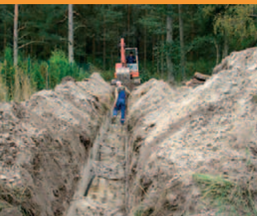
Maasoojuspumba kollektori kraavi paigaldamisel on heaks abileks väiketraktor.
