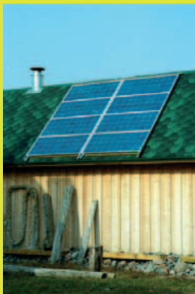
Päikesepaneel Naissaarel võimsusega 6x130W/12V.
