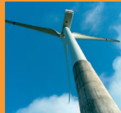
Viru-Nigula tuulepargis töötav tuulegeneraator võimsusega 3 MW.
