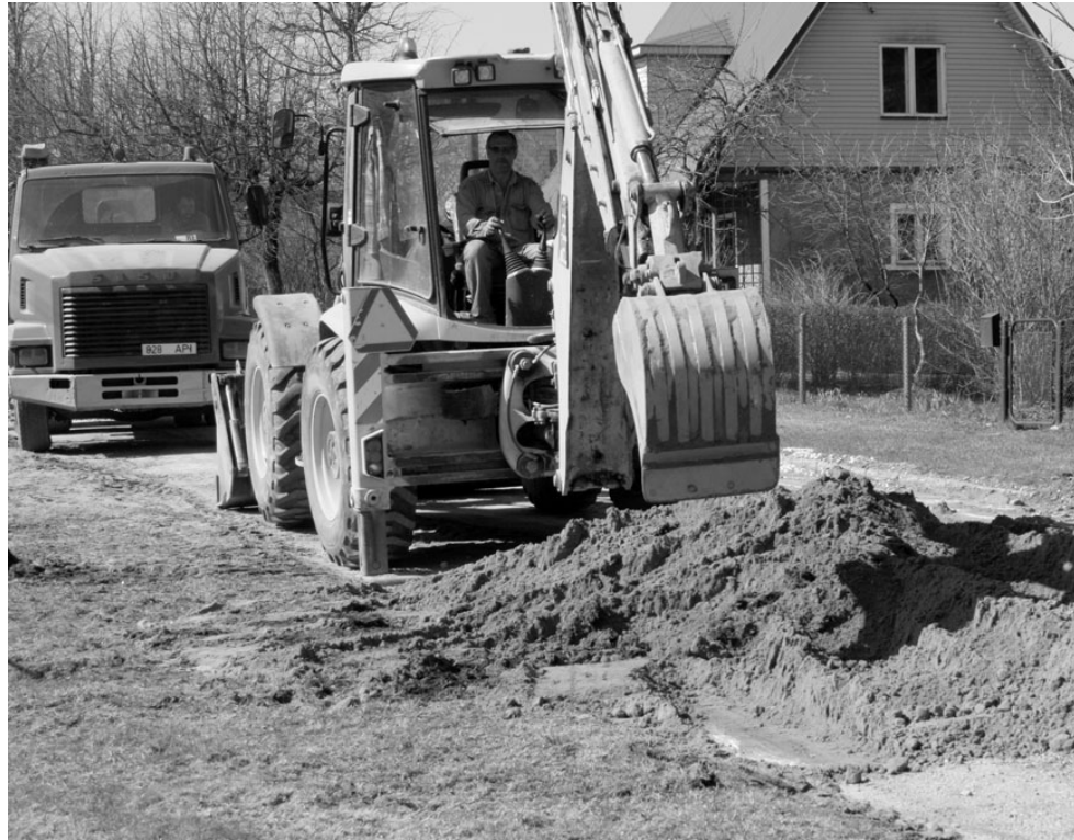
Sügiseks jõuab Facio Elvas vee- ja kanalisatsioonitrasside rajamisega Kesk tänavale välja. Foto: Kersti Koosa
