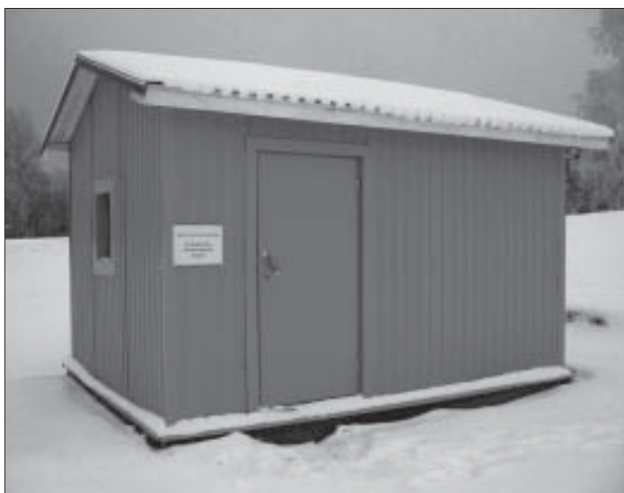
Koms vanade roostes raudtunnide asemele rajati uus pumplahoone, milles asuvad uued veepaagid, kompressor ja veepuhastusseadmed.
