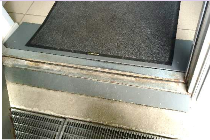
Korterelamu tasandusplekid paigaldatuna mõlemal pool läve, kummist alusega porimatt ja liikumist mittetakstav porirest.
