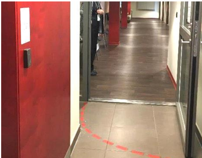
Tallinna sotsiaalameti automaatselt avaneva koridoriukse nn avanemiskaare tähistus põrandal ja „näita kaarti“ tekst seinanduril (paigalduskõrgus 1100 mm).
