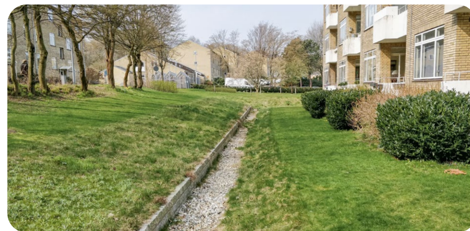
Täidisdreen kortermaja vundamendi kaitseks sõiduteelt valguga sademevee eest. Kopenhaagen, Taani. Foto: Gen Mandre.
