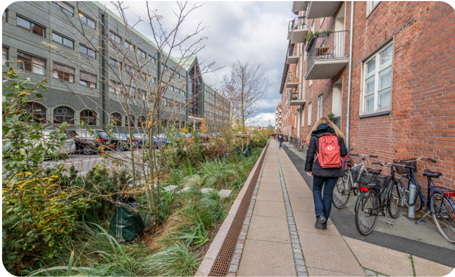
Vihmapeenar sõidu- ja kõnniteed eraldava ribana. Kopenhaagen, Taani. Foto: Kopenhaageni linnavalitsus.
