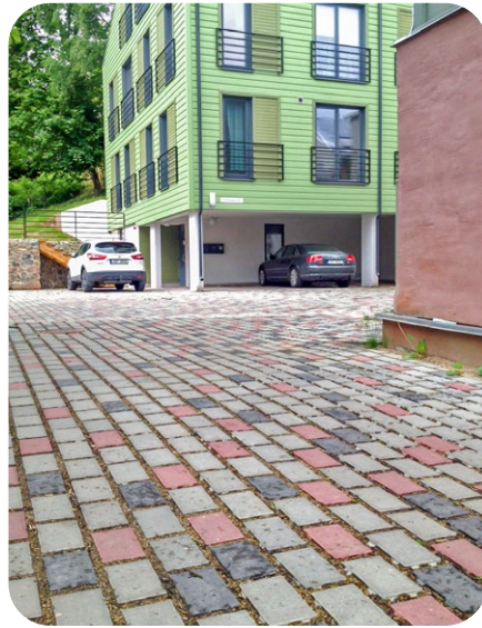
Vasakul: Plastkärg väiksema kasutuskoormusega parklas. Eesti. Foto: Gen Mandre. Paremal: Vahedega sillutuskivid. Tartu, Eesti. Foto: Gen Mandre.
