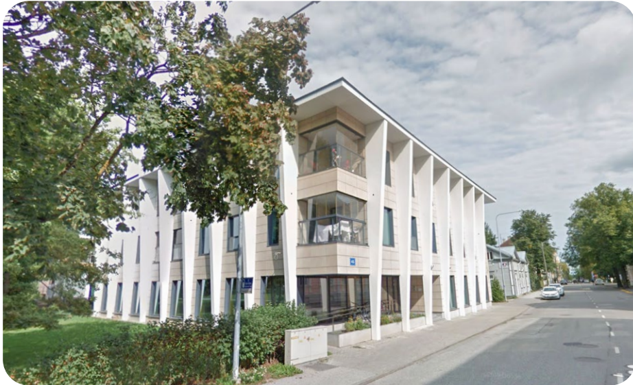
Sademevee kogumis- ja kasutamissüsteem Tartus, Vanemuise 45. Sambad varjavad vihmaveetorusid, mida mööda katuseelt kogutud sademevesi voolab maja alla peidetud 13 kuupmeetri suurusesse kogumispaki. Kogutud sademevett kasutatakse maja WC-pottides ja pesumasinate. Foto: Google Maps street view.
