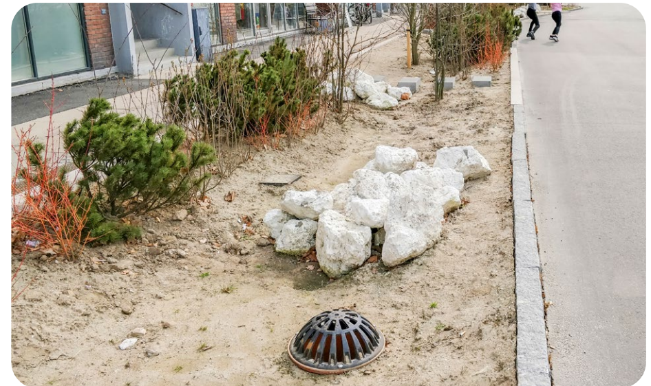
Imbkraav sõidu- ja kõnnitee eraldajana. Kopenhaagen, Taani. Foto: Gen Mandre.
