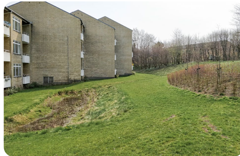
Puhverriba enne taimestatud nõva. Kopenhaagen, Taani. Foto: Gen Mandre.
