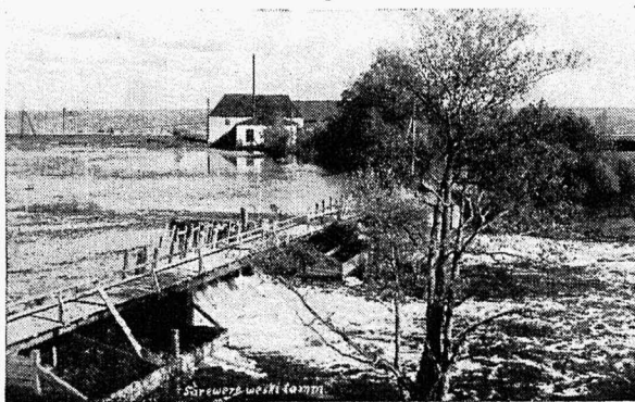
E. Viirman'i Säreveere saeveski ja elektrijaam Türil.
