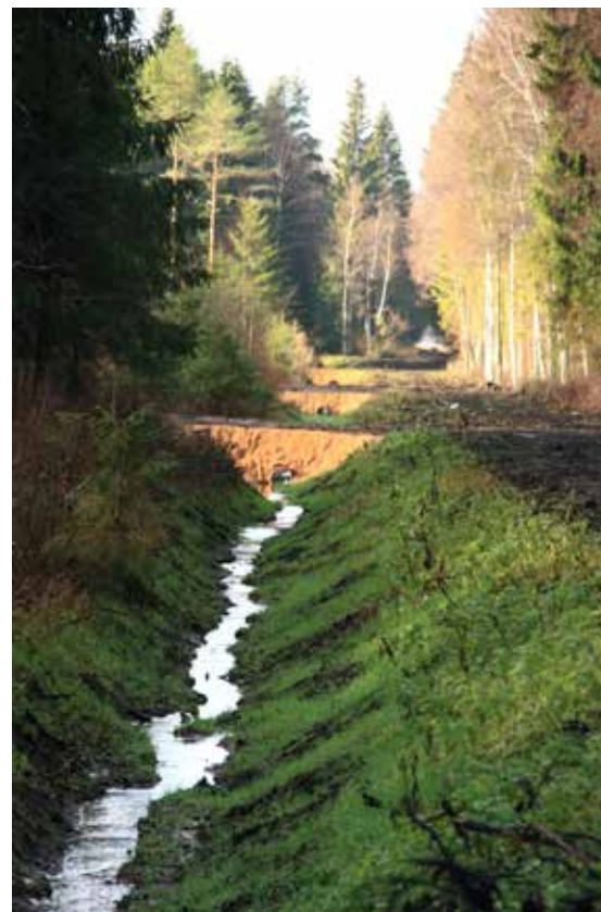
Foto 1. Meetme 1.8 käigus rekonstrueeritud Toovere objekti metsakuivenduskraav koos truupidega (Foto Toivo Vihalem)
