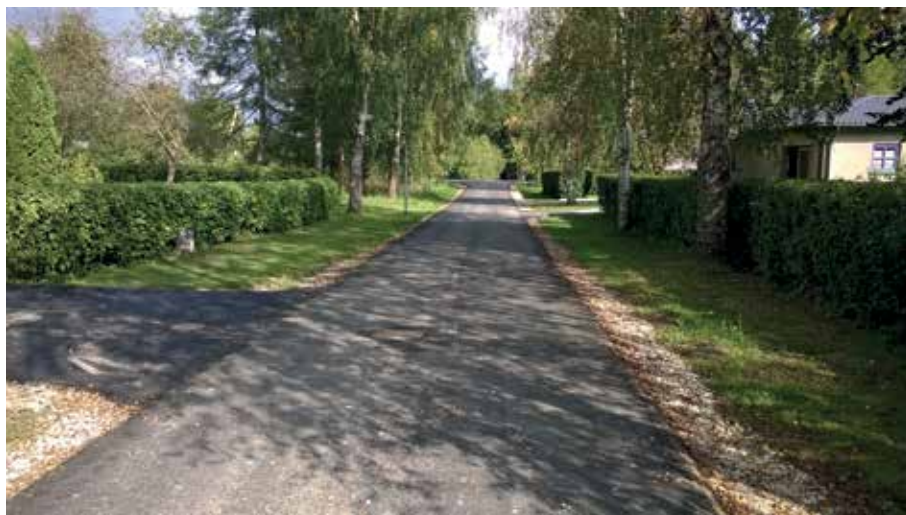
Laiuse aleviku vee- ja kanalisatsioonitorustiku rekonstrueerimine
