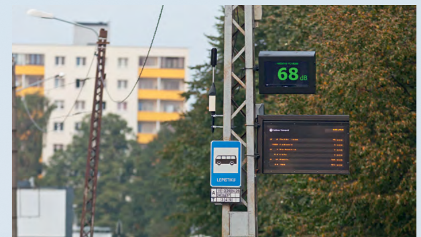
Sõpruse puiestee müratablo. Noise board at Sõpruse puiestee.
