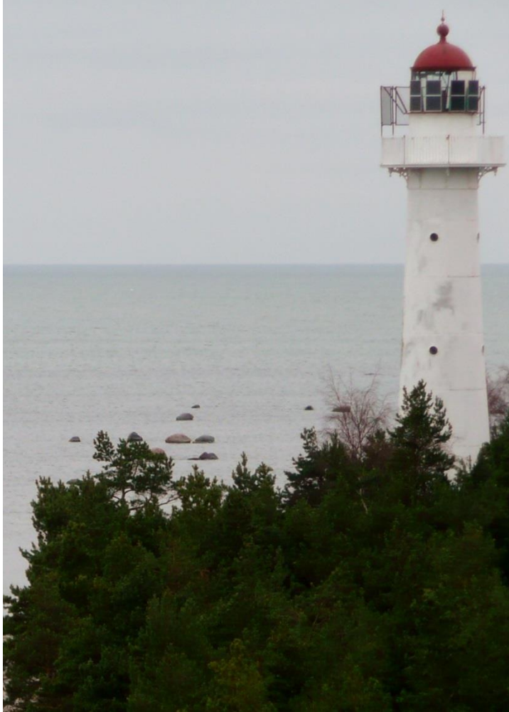
Vormsi (Saxby) tuletorn päikesepaneelide ja moodsate sektorlaternatega.
