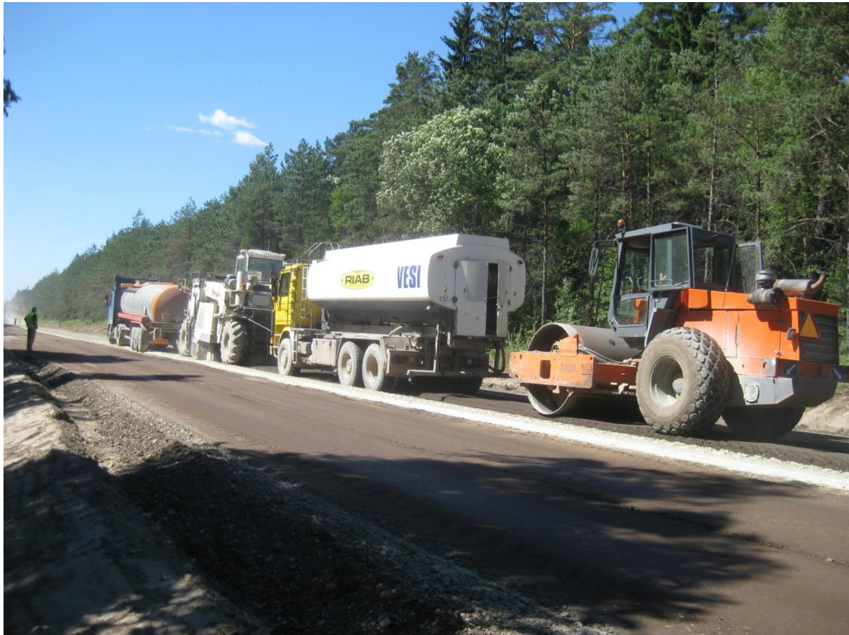
Risti – Palivere maanteelõigu remont. Foto: Maanteeamet.
