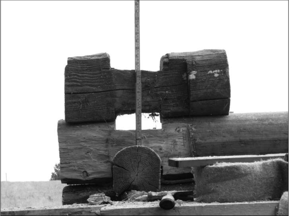
Nurgatapi kopeerimine: asenduspalk (all) on algse kõrgusega. Tahumine, pähik, alumine ja ülemine õnarus on tehtud algsete mõõtmete eeskujul ja töödeldud kirvega.
