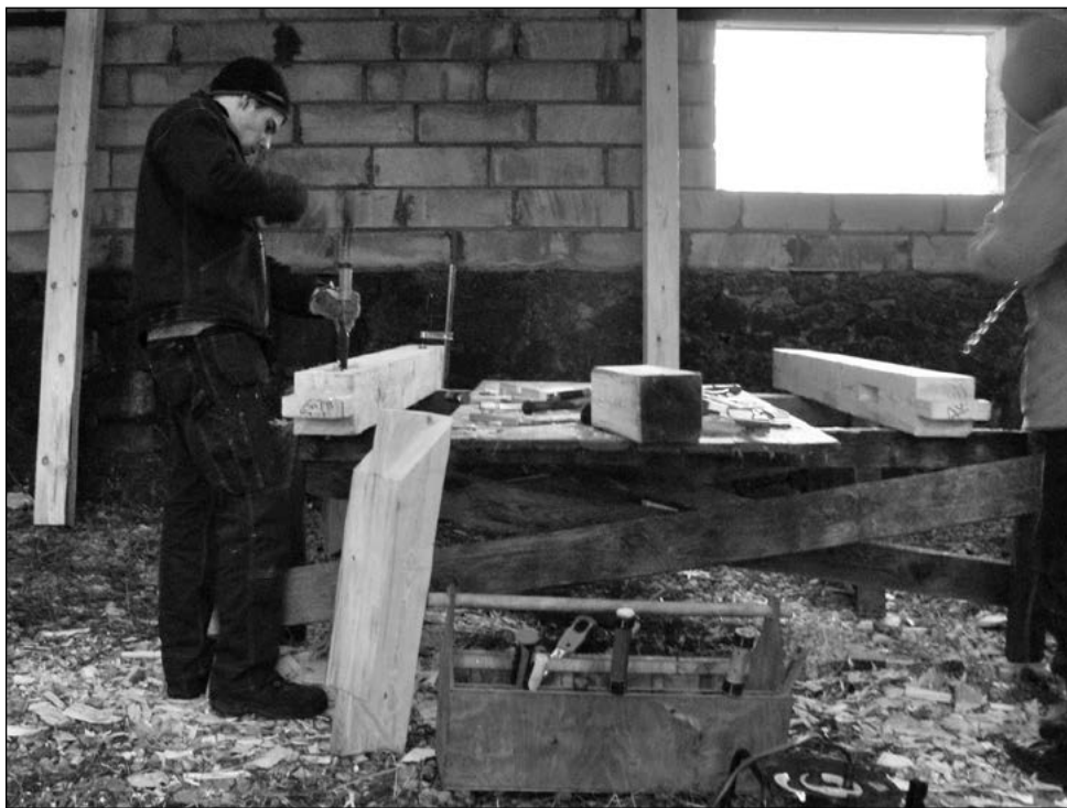
Sõrestik valmistati hoone sisse ajalooliste ehitustehnikate eeskujul, tappide ja tapi aukude tegemisel kasutati peitlit, käsisaagi jm käsitööriistu.
