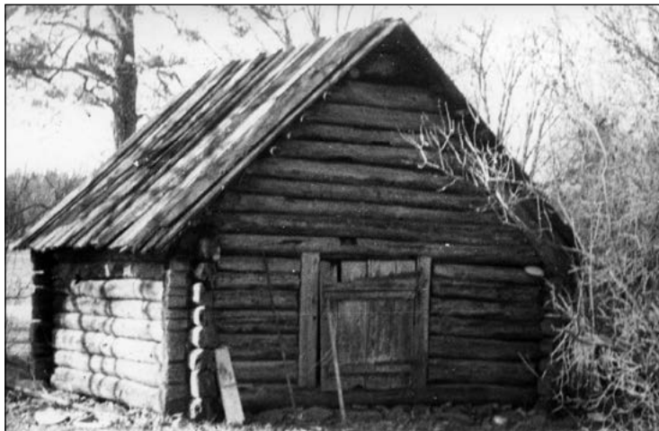
Kõstriaseme talu suveköök enne katuse sissevarisemist. Allikas: A. Heidmets.
