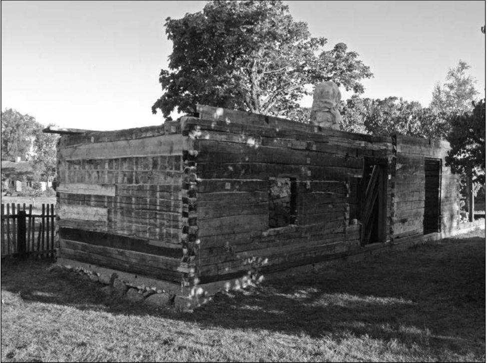
Hoone seinad valmimise järel: mitmest kohast jätkatud palgiredad jätavad ebaühtlase mulje. Seinad ja avad on algsest madalamad. Seestpoolt jätab hoone terviklikuma mulje, algne välimus on mitmeti muutunud.
