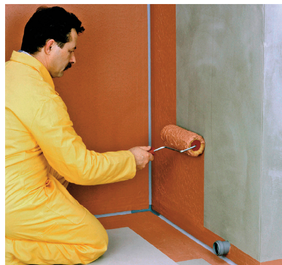
Hüdroisolatsioonimassi weber.tec 822 seinale kandmine maalerulliga.
