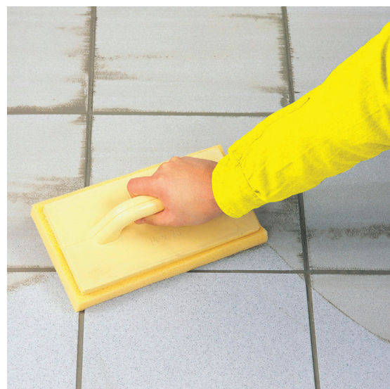
Plaadipindade puhastamine vuugisegust.
