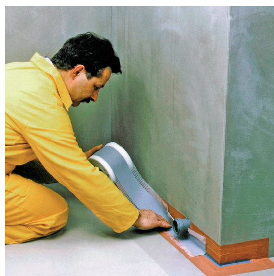
Hüdroisolatsioonilindi weber.tec 828 paigaldamine.
