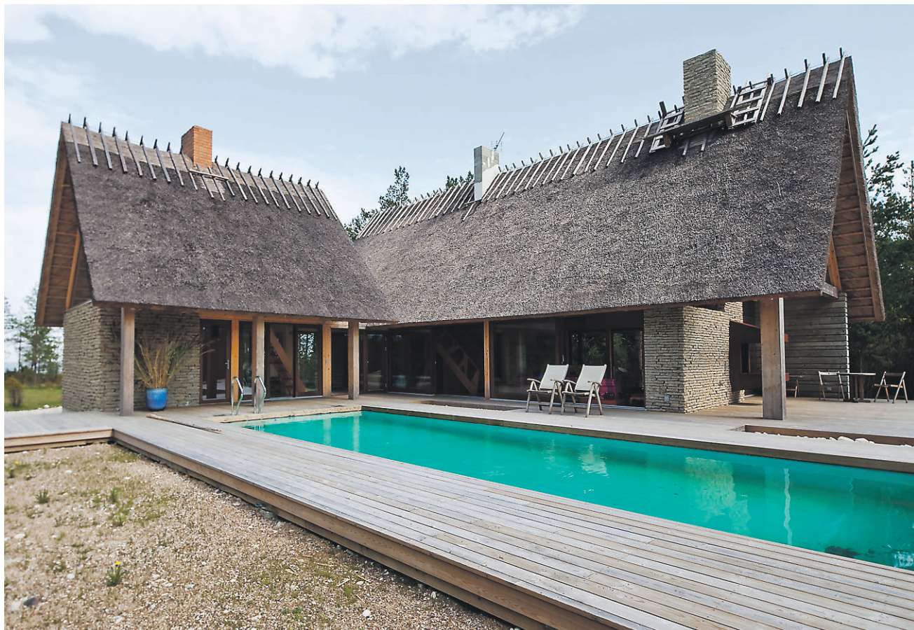
► Suvise õuelu keskmes on terrassiga palistatud basseini siseõuel.
