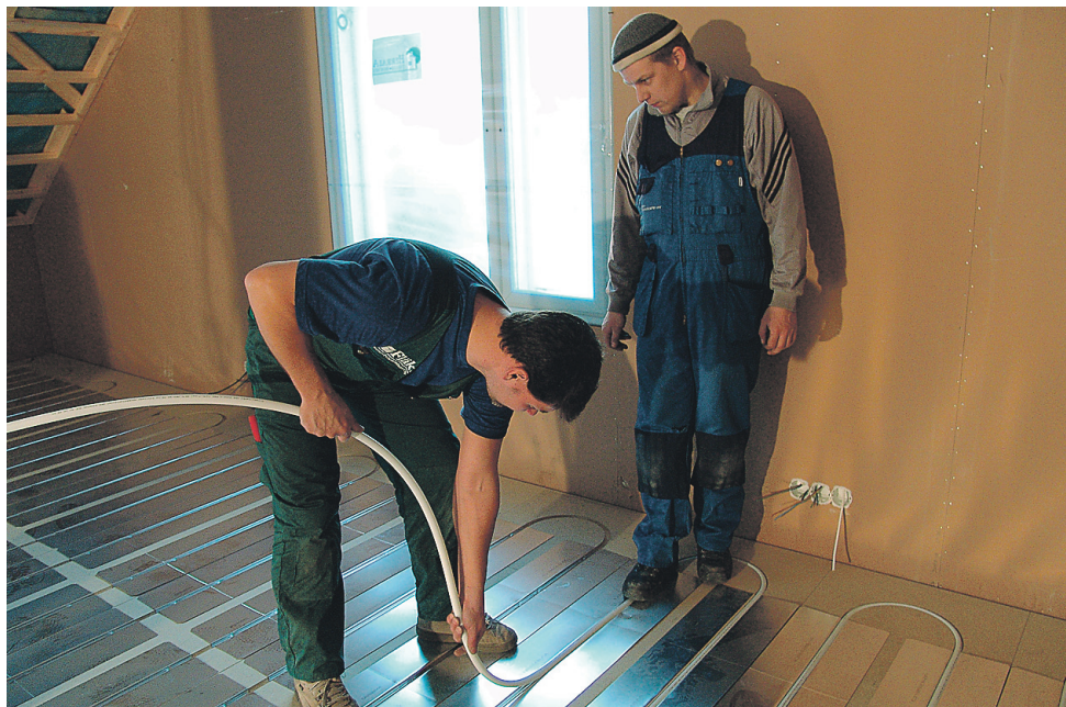
► Vesipõrandaküttetoru paigaldamisel puitpõranda alla tasub kasutada ka soojusjuhtimisplekke, et tõsta kütmise tõhusust.
