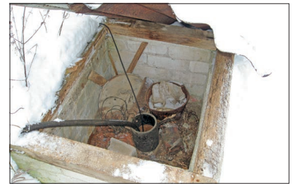
Kaks pilti sellest, kuidas ei tohi puurkaevu ja selle ümbrusega toimetada.
