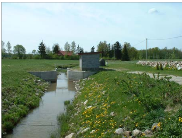
Joonis 1. Veeseire automaatjaam veekvaliteedi ja äravoolu kontrolliks.
