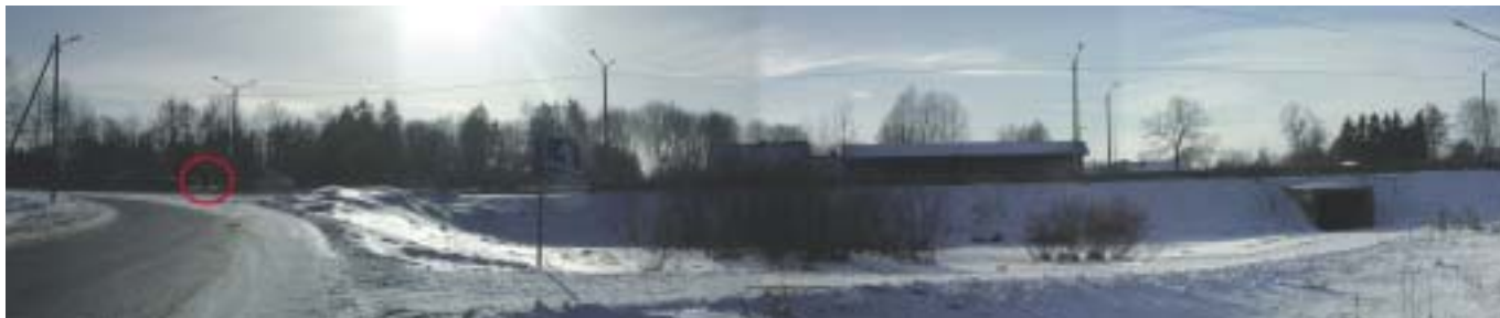
Olukord Assakul. Et tunnel on vett täis, siis ületatakse Tallinna – Tartu maanteed samas tasapinnas. Ülekäigu lihtsustamiseks on eraldusribalt piirde eemaldatud.
