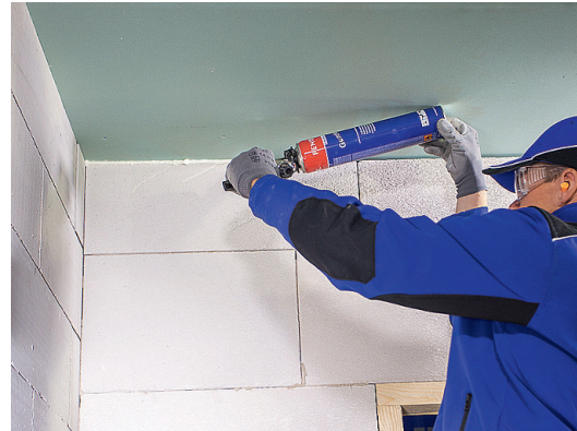
↑ LAE ja seina vahele jäetud 10-20 mm vahe täida montaaživahuga.
