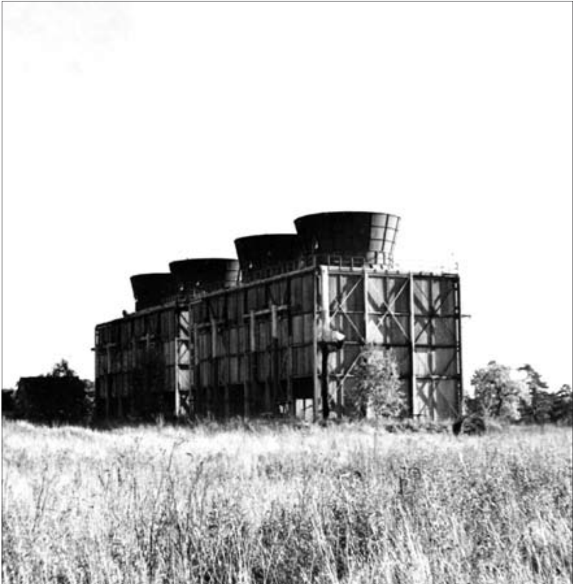
Jahutusvee gradiirid enne objekti ülevõtmist.
