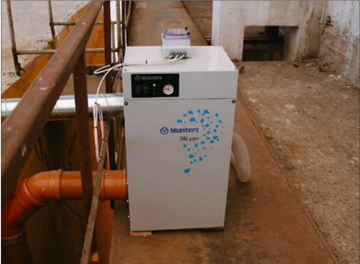
Niiskuskahjustuste vältimiseks on teise õppeendi reaktorisarkofaag varustatud dehumifikaatoriga (niiskuseemaldiga).
