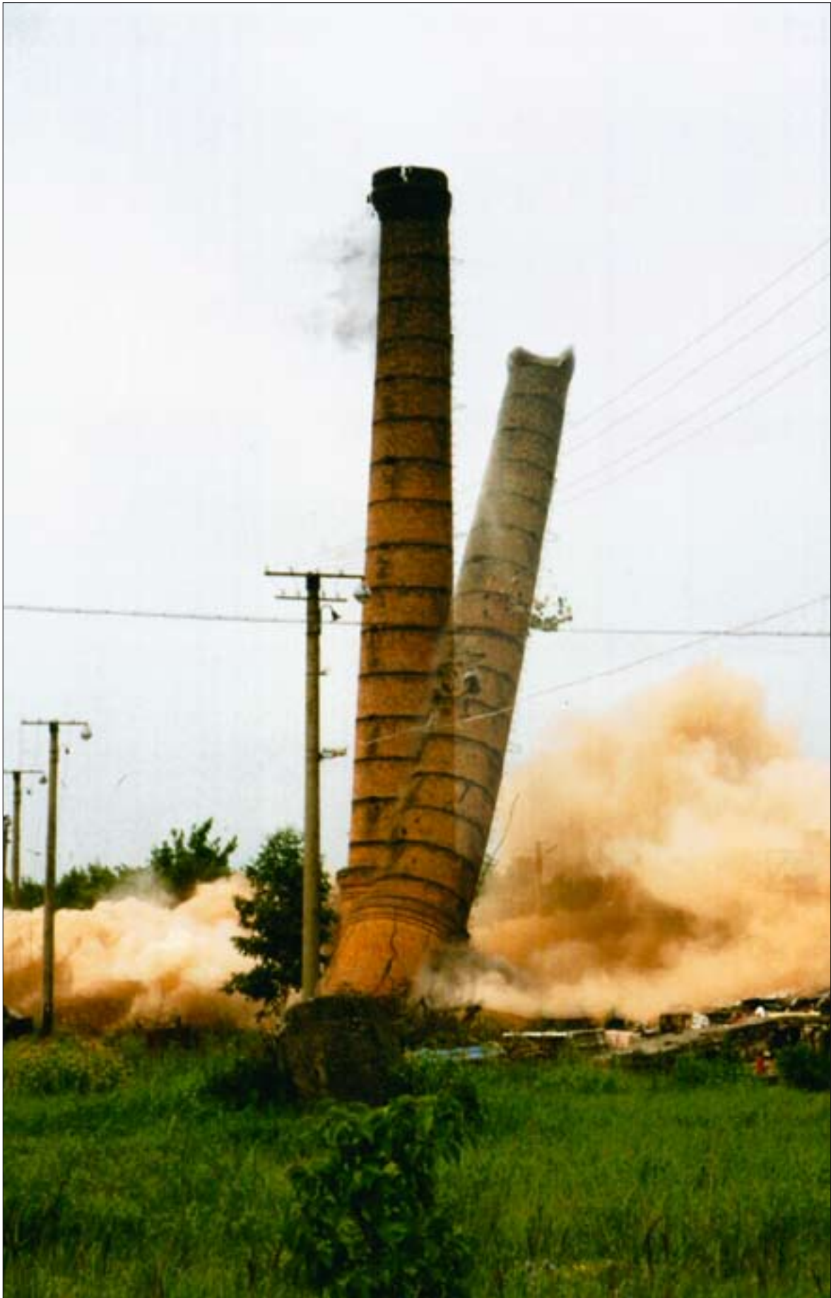
Masuudireostuse peasüüdlase – tuumaobjekti katlamaja – korstna õhkimine. Suvi 1996. a.
