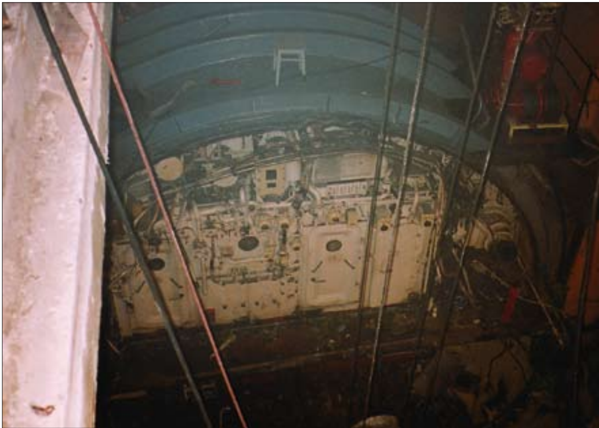
Aasta 1995. Teise õppestendi reaktorisektsioon enne sarkofaagi rajamist. Reaktorisektsiooniga otseselt mitteseotud seadmed on juba eemaldatud. Otsvaade.
