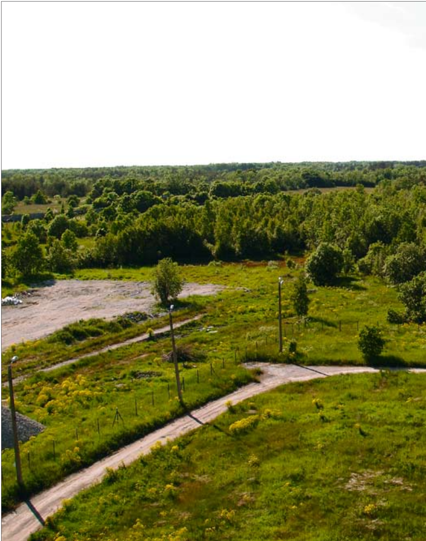
1995. aastal tihedalt ehitisi täis plats on 2005. aastaks tühi ja rohelusse mattunud. Tuumaobjekti naabriks on saanud Pakri tuulepark ja järjest rohkem inimesi asub elama omal ajal kinniseks linnaks olnud Paldiskisse. Loodame, et kunagi muutub Pakri poolsaar taas puhtaks ja rõõmsaks kohaks nagu ta oli Eesti Vabariigi algusaastatel.
