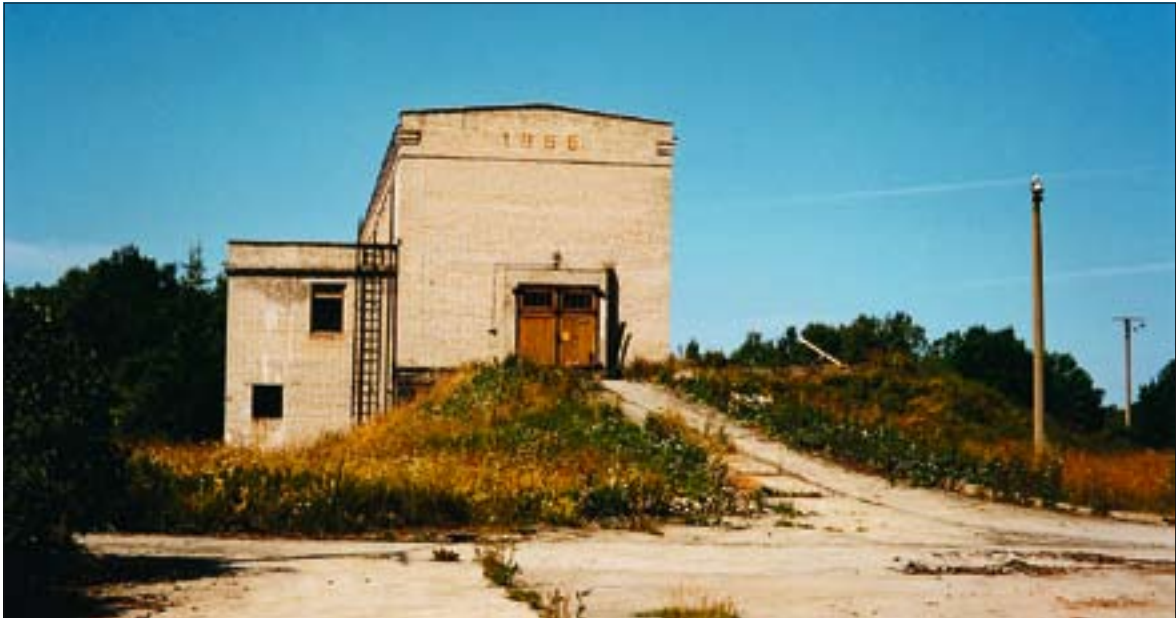
Vedeljätmete hoidla 1996. aastal. Vaade lõunast.
