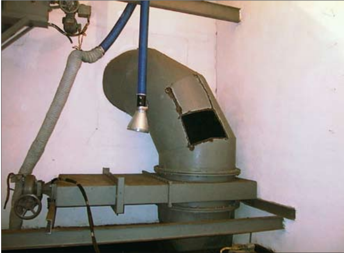
Saastunud seadmete eemaldamine ventilatsioonihoones.
