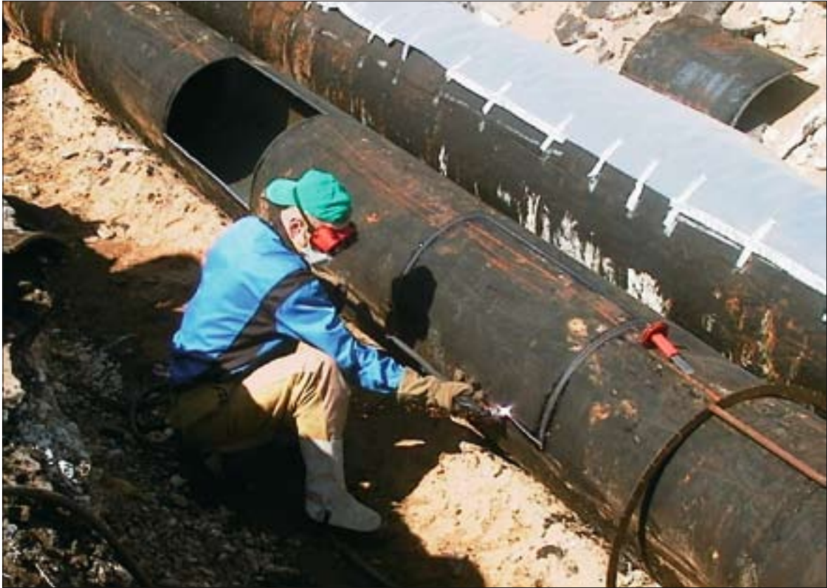
Pärast saastunud hoonete puhastamist ja lammutamist asuti saastunud kanalisatsiooni- ja ventilatsioonitrasside väljakaevamisele, tükeldamisele ja puhastamisele.
