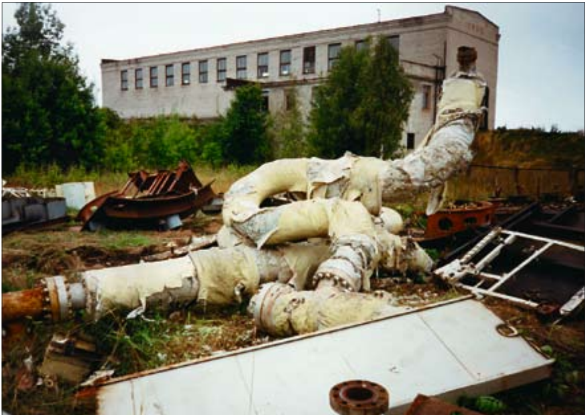
Asbestiga kaetud demonteeritud metalldetailid Paldiski tuumaalveelaevnike õppekeskuse tuumaobjekti territooriumil selle ülevõtmise ajal.
