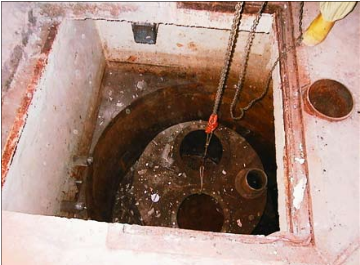
Radioaktiivsete vedeljäätmete töötlemiskompleks. Saastunud seadme eemaldamine.
