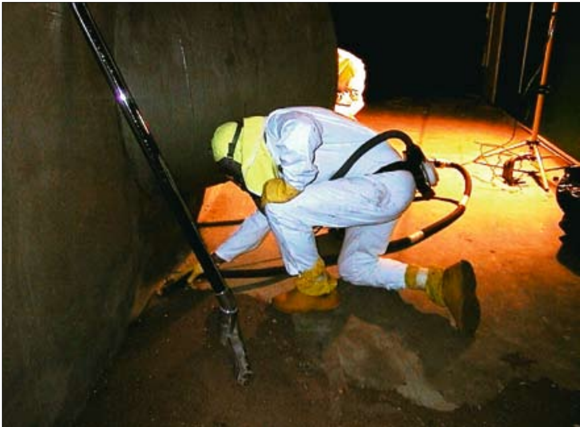
Saastunud liivakihi eemaldamine ventilatsioonihoones tõmbekoridori põrandalt.
