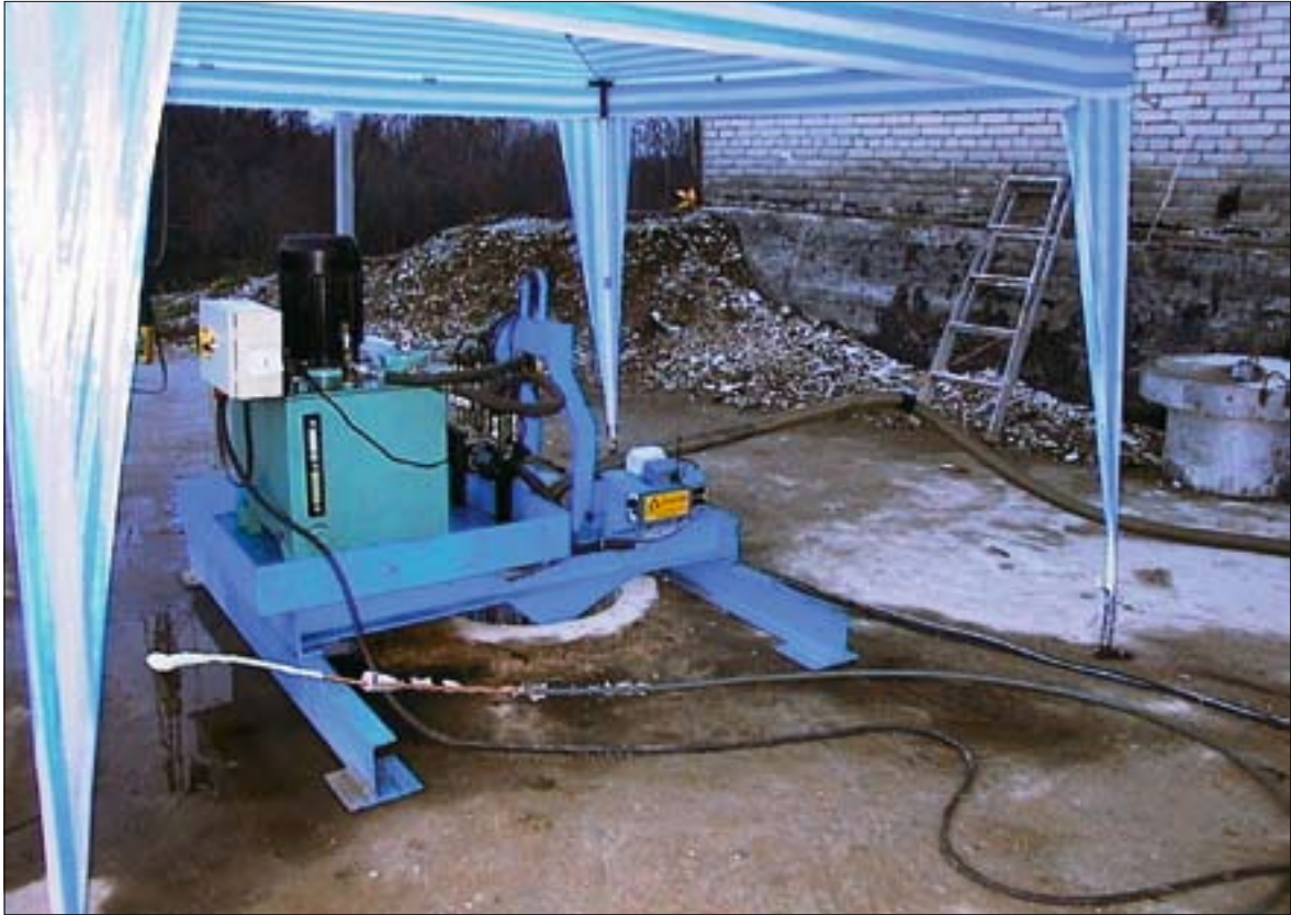
Radioaktiivsete tahkete jäätmete hoidla tühendamisel kasutatud robotkraana leidis taas rakendust radioaktiivsete vedeljäätmete hoidla mahutiseadmete eemaldamisel.
