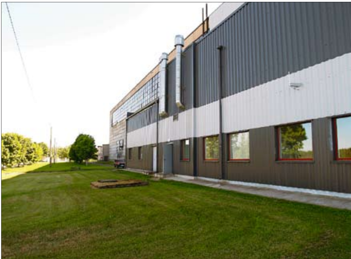
Vaade Paldiski tuumaobjekti osaliselt renoveeritud peahoone idaküljele 2005. aastal.
