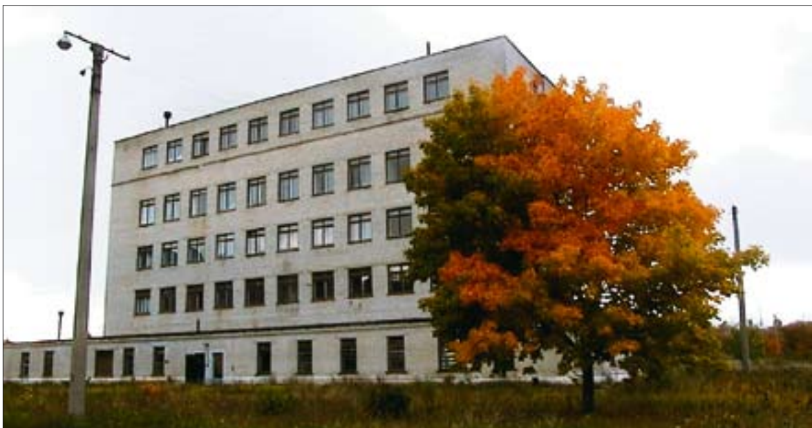
Vedeljäätmete töötlemiskompleks 2001. aastal.
