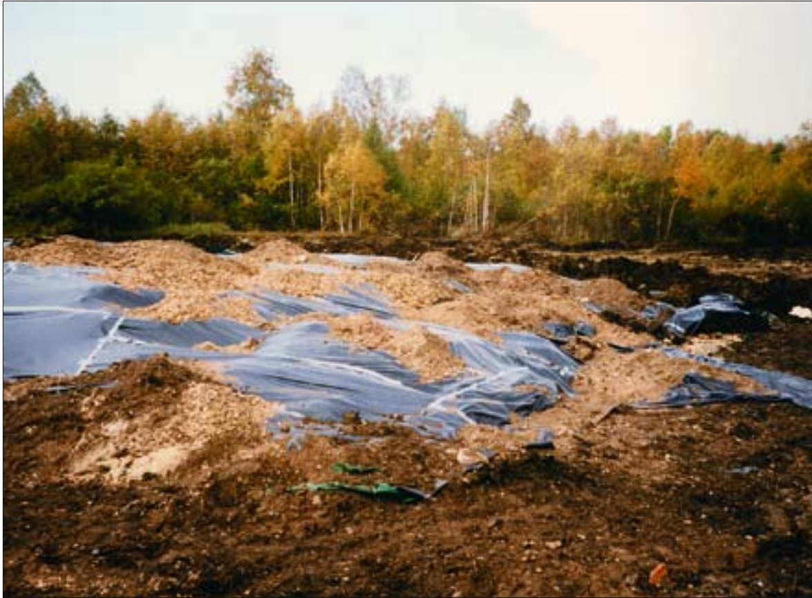
Õliga reostunud pinnasevaalud väljaveo ootel.
