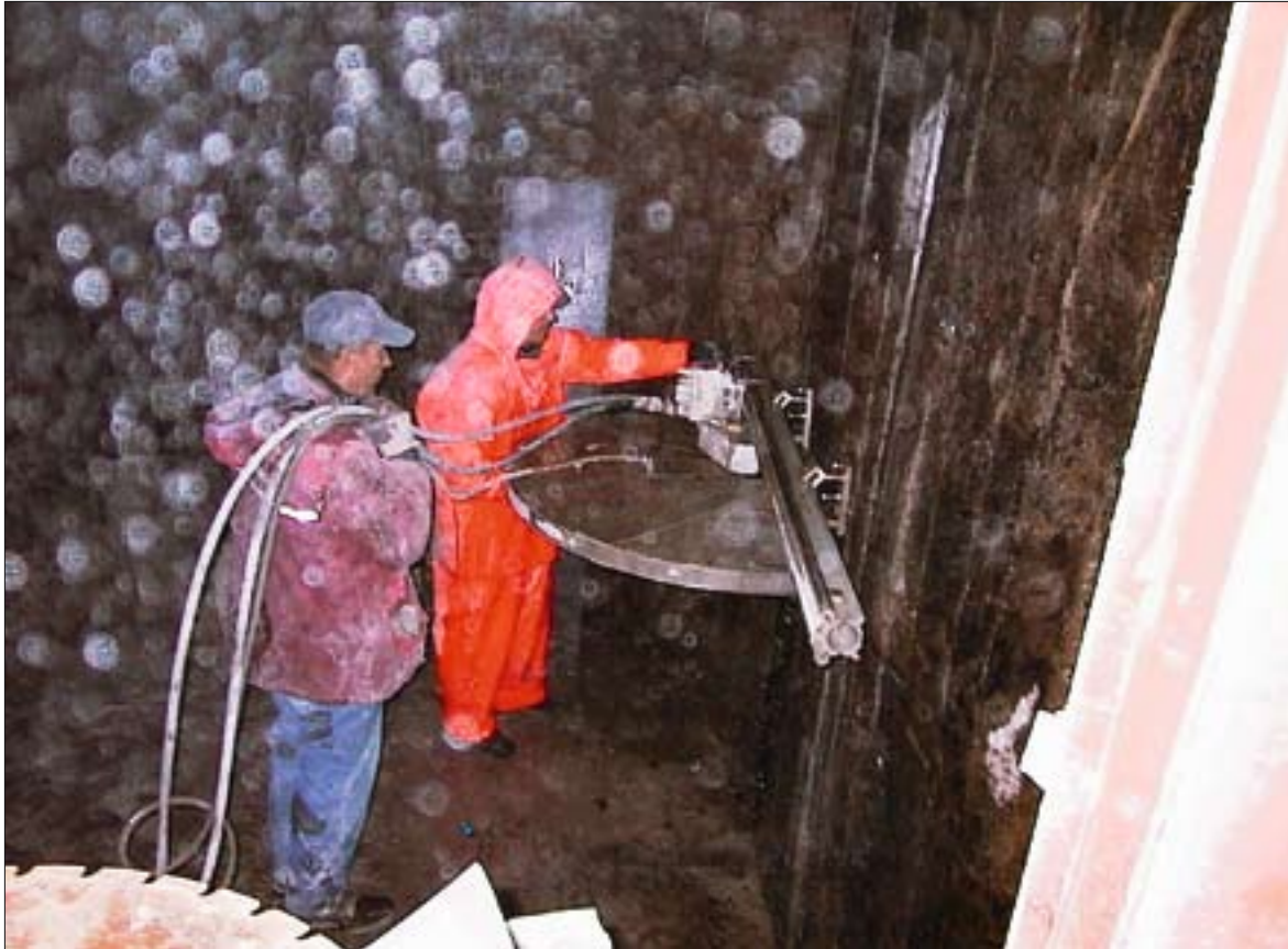
Pääsuks radioaktiivsete vedeljäätmete töötlemiskompleksi mahutitesse lõigati nende seintesse ukseavad.
