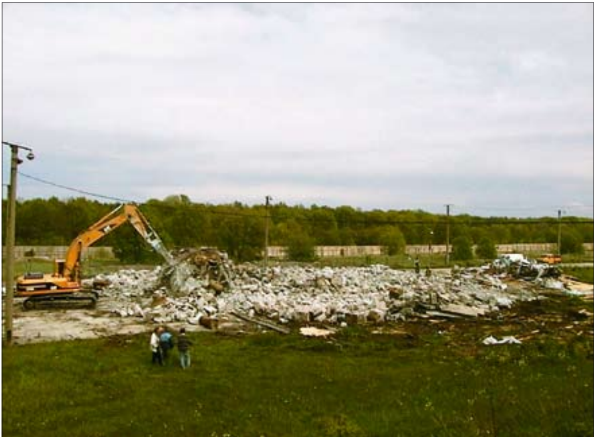
Radioaktiivsete tahkete jäätmete hoidla lammutamine.
