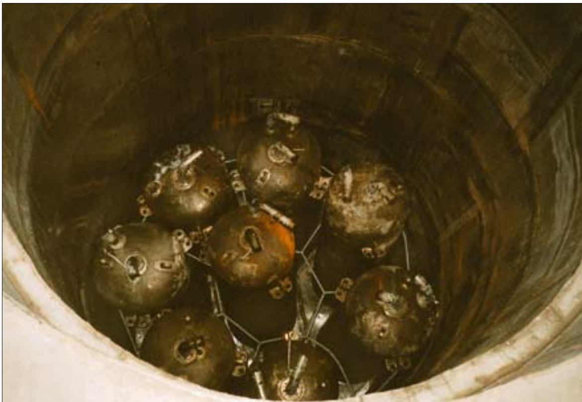
Tahkete jäätmete hoidlast eemaldatud aurugeneraatorid, mis oma mõõtmete tõttu kasutatavatesse jäätmekonteineritesse ei mahtunud, ladustati pärast desaktiveerimist, jääkvee eemaldamist ja kõikide avade kinnikeevitamist peahoones asuvas endises tuumakütuse jahutusbasseinis.
