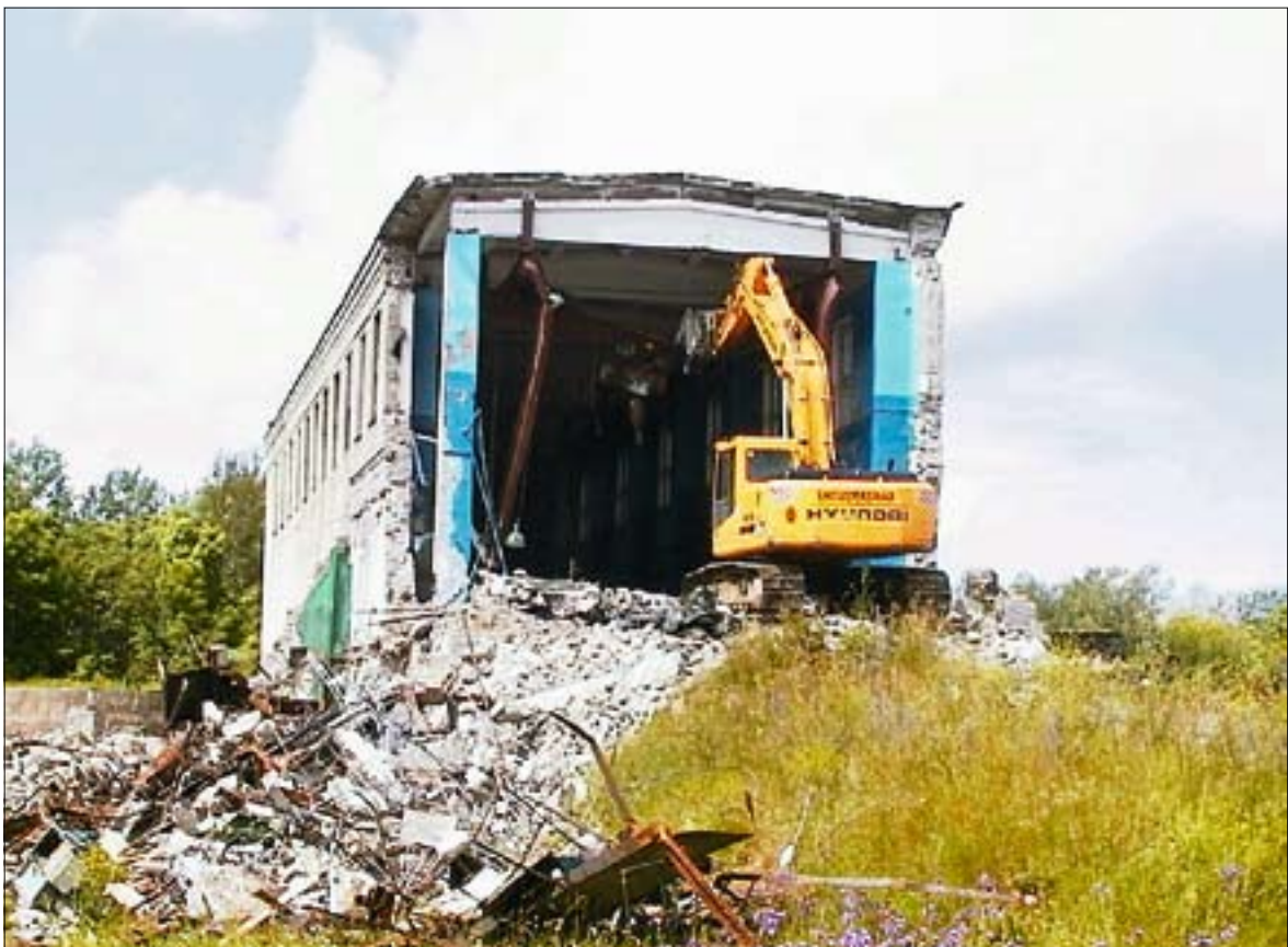
Radioaktiivsete vedeljäätmete hoidla lammutamine.
