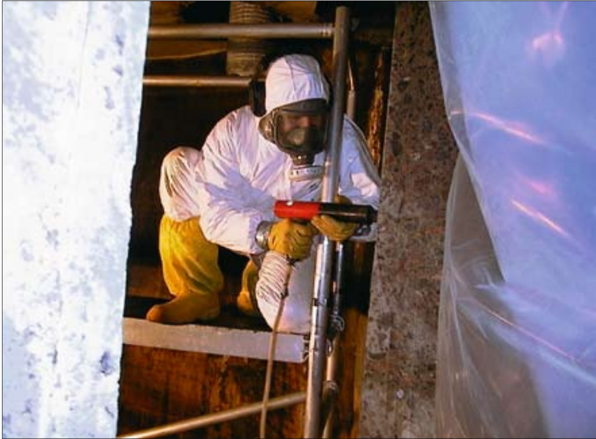
Radioaktiivsete vedeljäätmete töötlemiskompleksi puhastustööd. Saastunud mahuti seinte puhastamine nõelkoorija abil.
