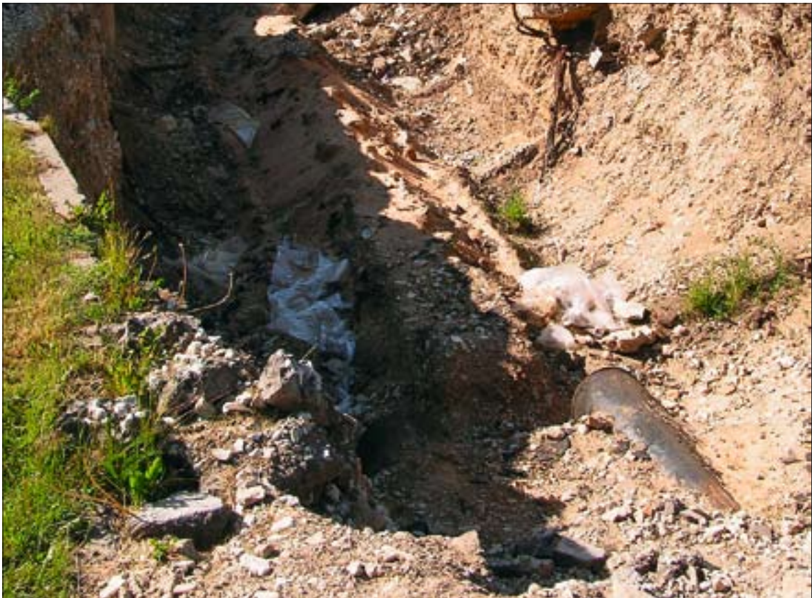
Ventilatsioonitrassilt on saastunud ventilatsioonitorustik eemaldatud.
