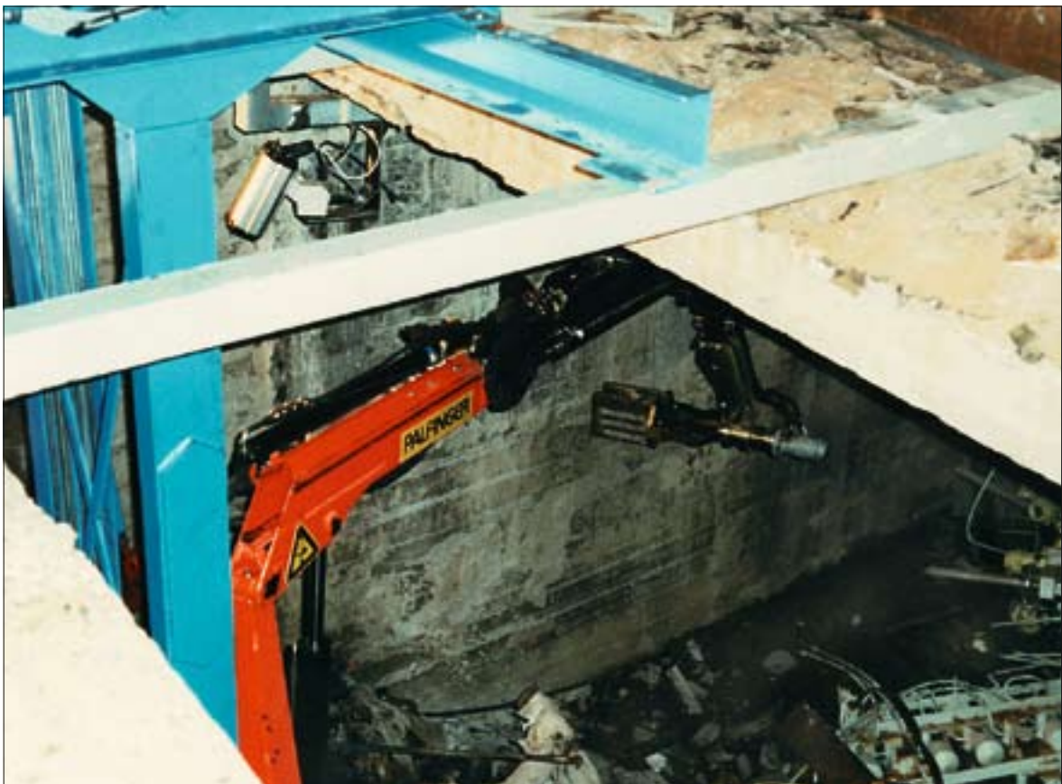
Kõrge aktiivsusega jäätmete eemaldamiseks oli kasutusel kaugjuhitav robotkraana.
