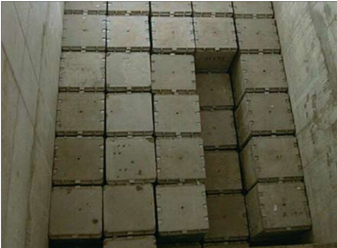
Radioaktiivsete jäätmete vahehoidlasse paigutatud jäätmekonteinerid.
