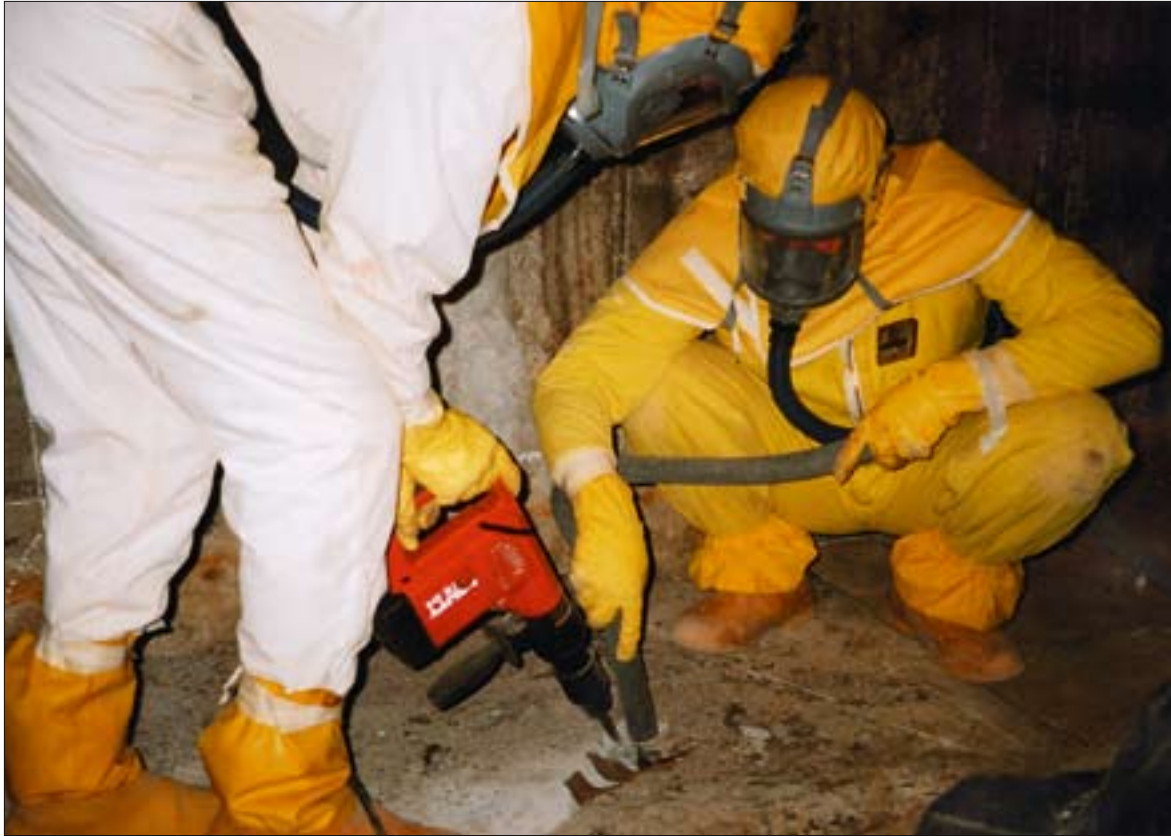
Sügavale tunginud saaste korral võeti kasutusele piikvasar ja saastunud koht raiuti välja vajaliku sügavuseni, mistõttu tekkisid puhastatavatesse seintesse sügavad orvad.
