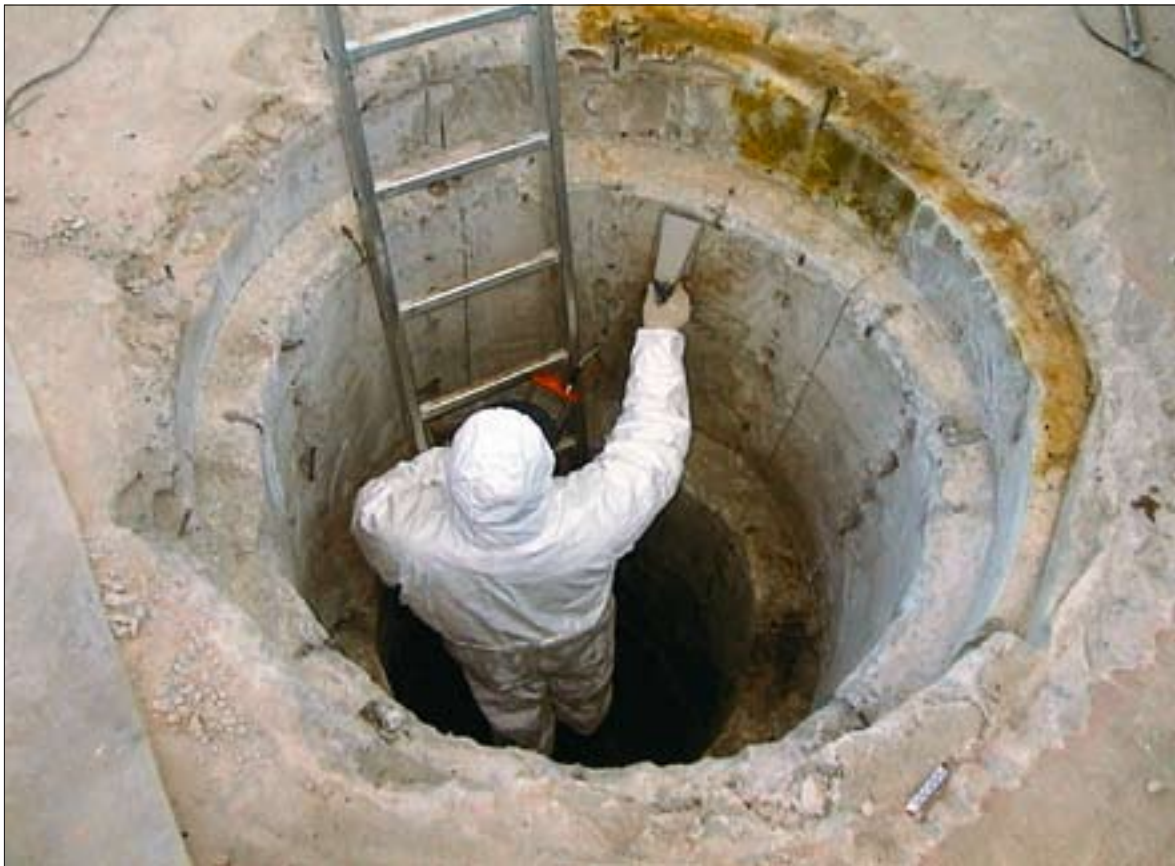
Enne radioaktiivsete vedeljäätmete hoidla lammutamist viidi saastusest puhastatud hoones läbi kiirgusuuring.
