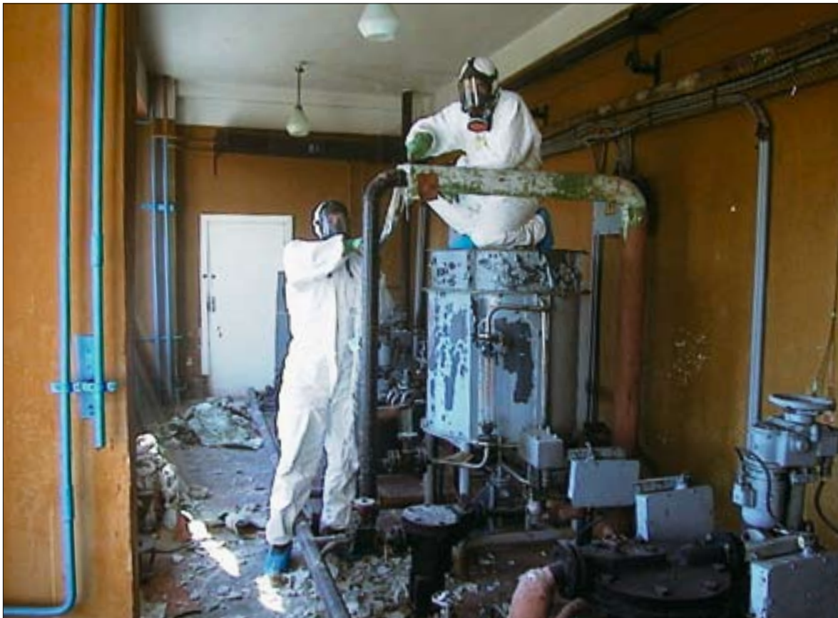
Radioaktiivsete vedeljäätmete töötlemiskompleks. Radioaktiivselt saastunud asbestikihi eemaldamine seadmetelt.
