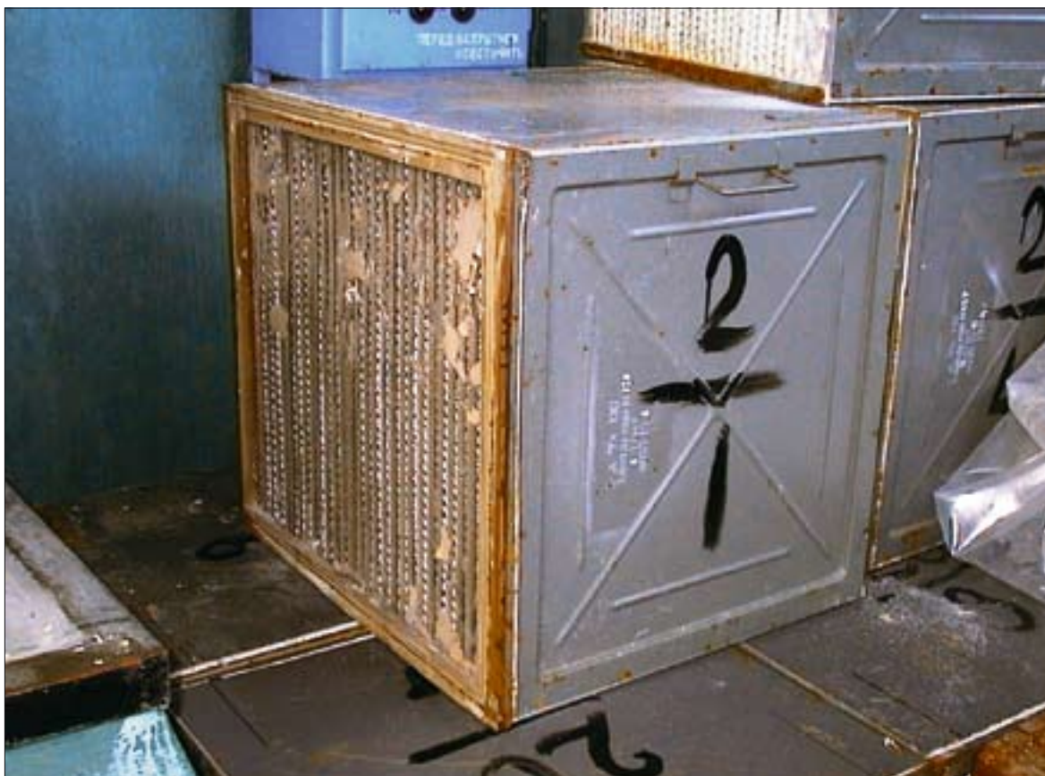
Ventilatsioonisüsteemis kasutatud HEPA filtri plokk.
