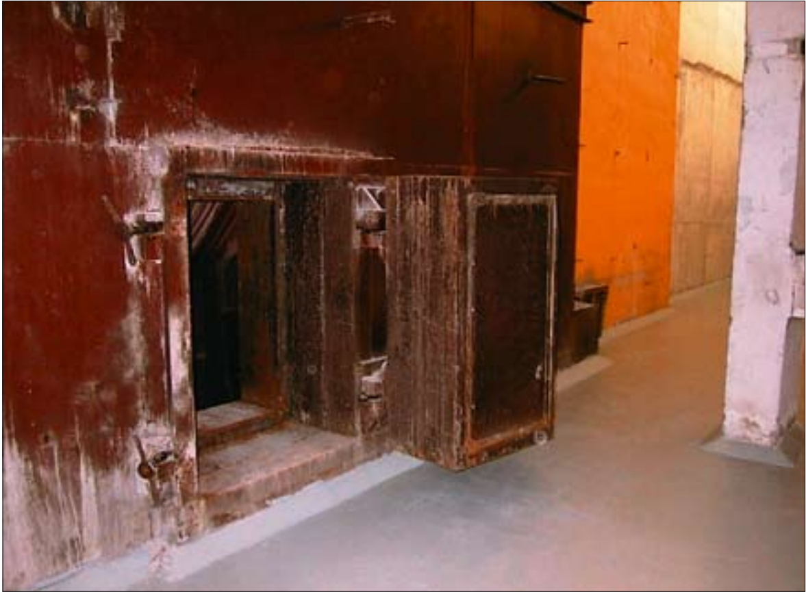
Teise õppestendi reaktorisektsiooni meetripaksune metalluks pääsuga reaktorialusesse ruumi.
