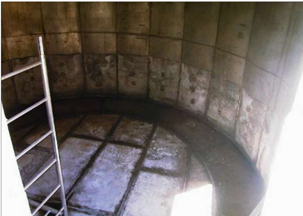
Üks radioaktiivsest saastest puhastatud radioaktiivsete vedeljäätmete töötlemiskompleksi mahuti. Mahutite roostevabast terasest sisevoorderdus puhastati liivapritsiiga ning eemaldati mahuti allosas, kontrollimaks voorderduse aluste betoonpindade puhtust.
