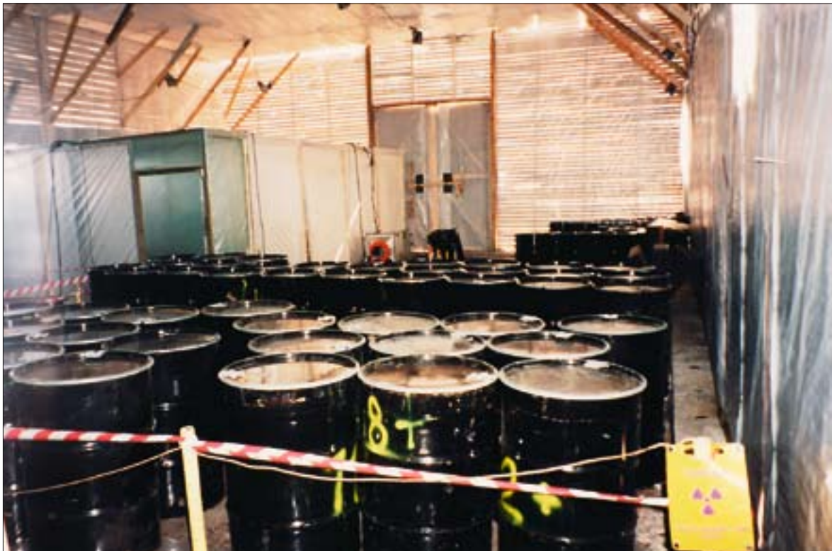
Jäätmekonteinerite puudumisel kasutati tahkete radioaktiivsete jäätmete hoidlast eemaldatud jäätmete ladustamiseks esialgu 200 liitriseid vaate. Fotol on vaadid ladustatud tahkete jäätmete hoidla lael kattehitise all. Vasakus tagumises nurgas paistab pealt avatud jäätmesektsiooni kohale saaste leviku piiramiseks rajatud täiendav kilehoone. Samast, esimesena tühjendatud sektsioonist pärinevate jäätmetega on täidetud kõik pildil nähtavad vaadid.
