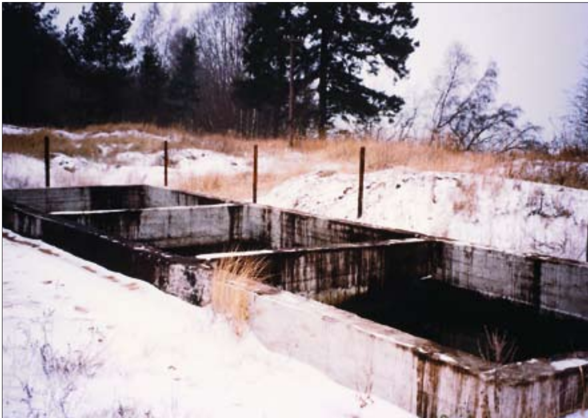
Tuumaobjekti kanalisatsioonisüsteemi suublas Lahepere lahe kaldal paiknev õlipüüdur hoiab ära drenaaživetes leiduva jääkõli merre sattumise.
