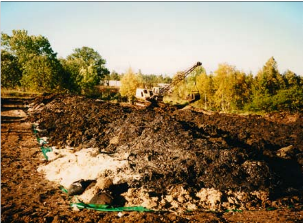
Õliga reostatud pinnas kooriti ja kuhjati vaaludesse.
