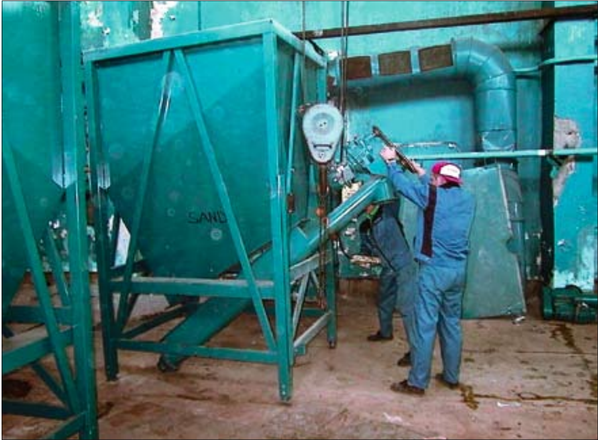
Radioaktiivsete vedeljäätmete hoidla mahutisetete tahkestamiseks vajalike seadmete montaaž hoidla peasaalis.
