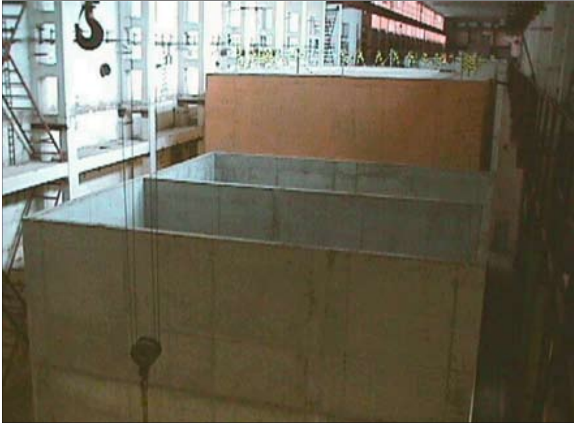
Valmishitatud vahehoidla koos teise õppetendi reaktorisektsiooni ümbritseva sarkofaagiga. Vaade põhjast.
