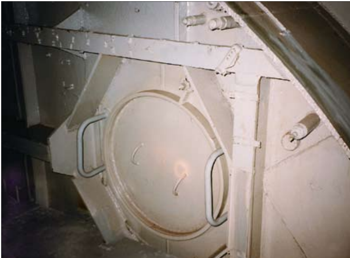
Teise õppetendi reaktorisektsiooni kinnikeevitatud sissepääs.
