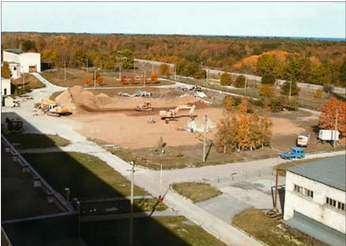
2002 aasta sügis. Radioaktiivsete vedeljäätmete töötlemiskompleksi lammutustööd on jõudnud lõppjärku. Vaade Paldiski tuumaobjekti peahoone katusest.
