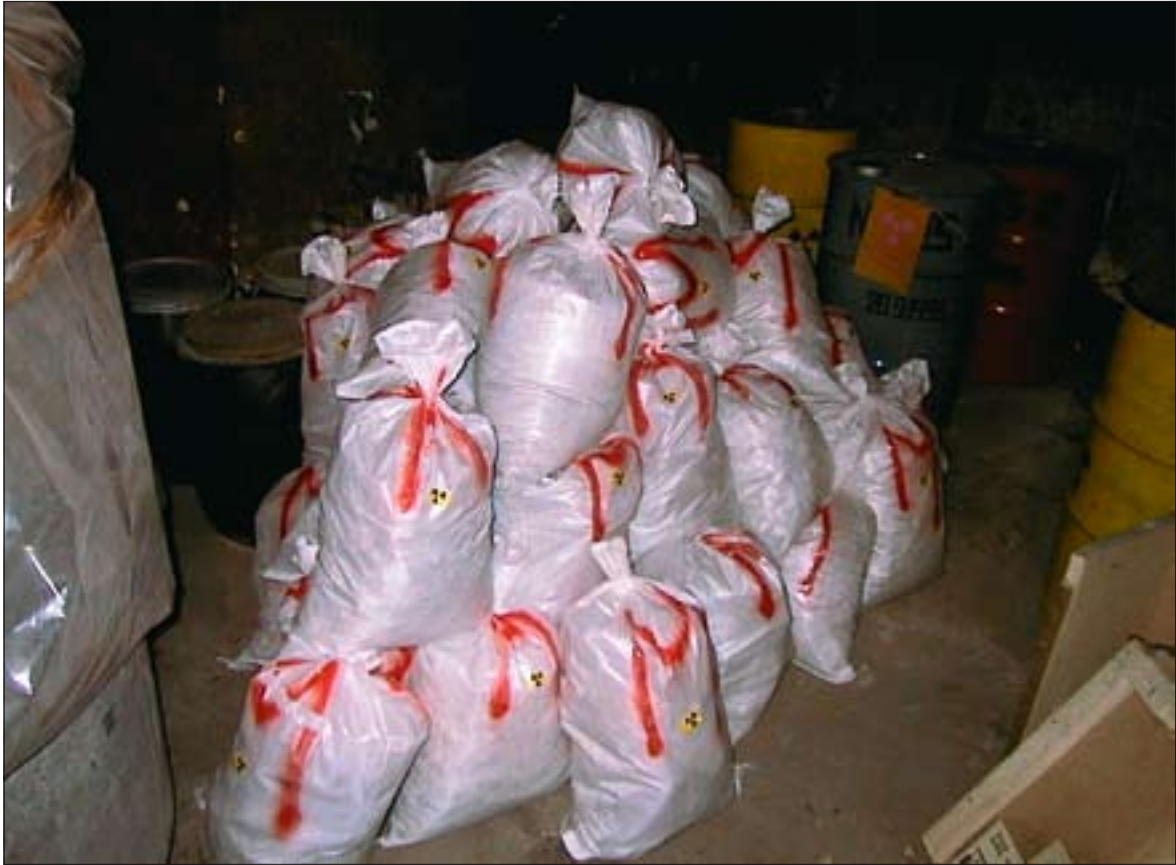
Radioaktiivsete vedeljäätmete töötlemiskompleks. Seadmetelt eemaldatud radioaktiivselt saastunud asbest väljaveo ootel.
