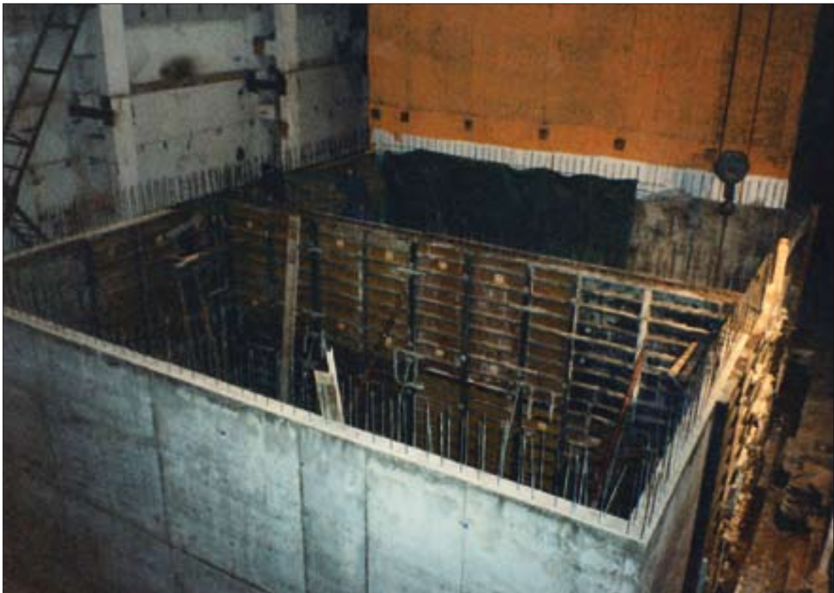
Sama vaade aastal 1997. Teise õppetendi reaktorisektsioon on ümbritsetud sarkofaagiga (värvitud kollaseks), vahetult selle naabrusesse rajatava radioaktiivsete jäätmete vahehoidla ehitustööd on jõudnud lõppjärku.
