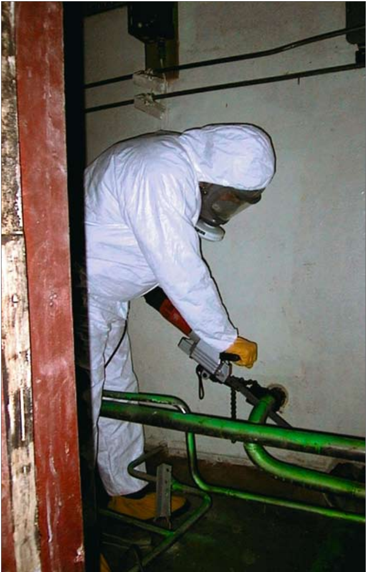
Radioaktiivsete vedeljäätmete töötlemiskompleksi puhastustööd. Saastunud torustike tükeldamine.
