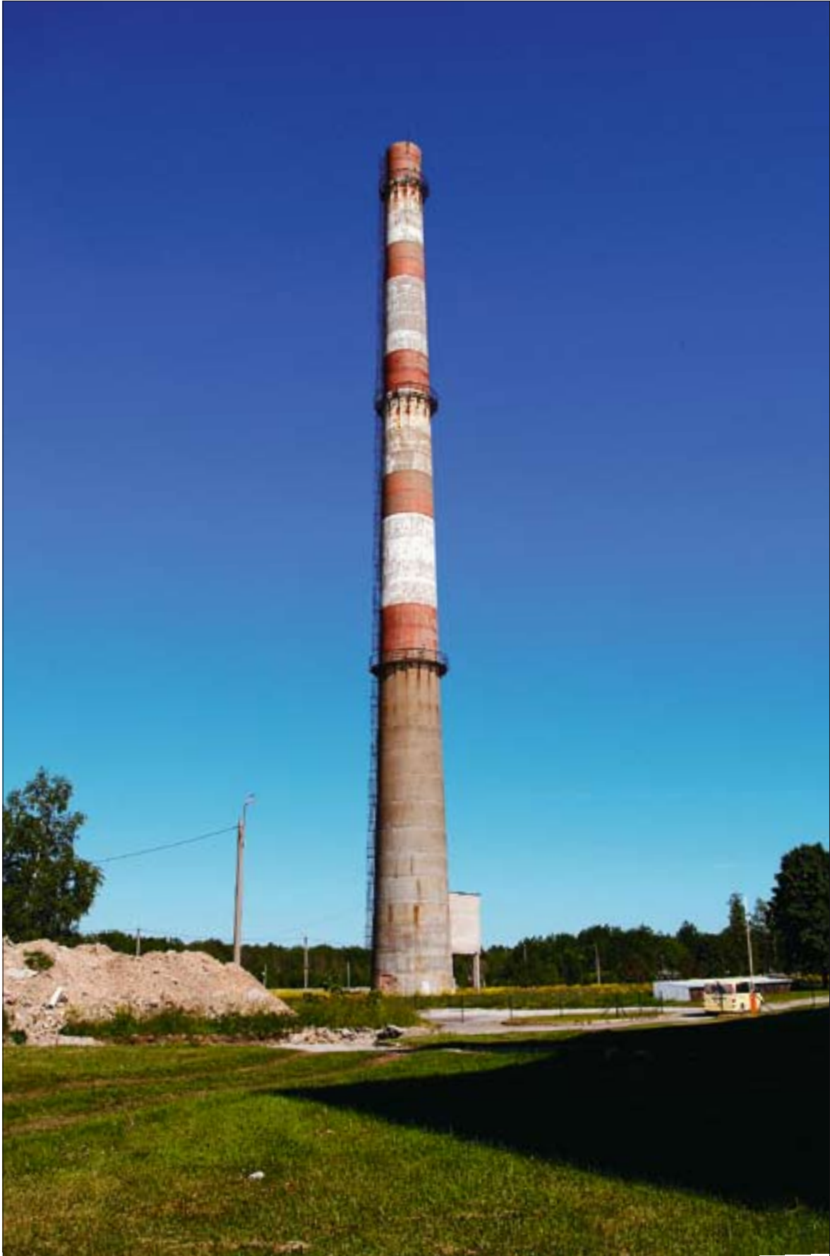
Paldiski tuumaobjekti 100 meetrine korsten, mis nõukogude ajal valmistas uudishimulikele palju peamurdmist kui “korsten, millest ei tule kunagi suitsu”. Tegelikuses on korsten osa ventilatsioonisüsteemist ja tema suur kõrgus oli vajalik võimaliku avari korral tekkivate ning ventilatsioonisüsteemi sattuvate radioaktiivsete aerosoolide hajutamiseks.
