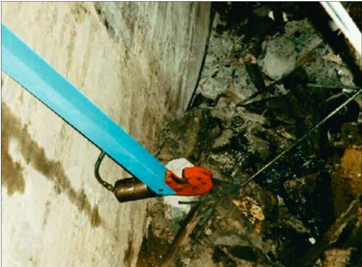
Juhtvardad lõigati sobiva pikkusega tükkideks hoidla sektsiooni paigutatud kaugjuhitava hüdraulilise lõikuri abil.
