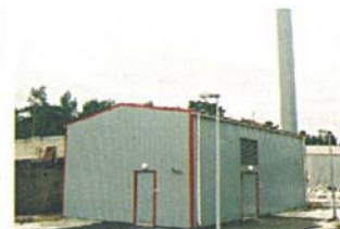
Tallinna Tehnikaülikooli 7,02 MW katlamaja
