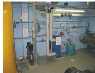
Katlamaja deaeraatorsüsteem ja lisavee süsteem
