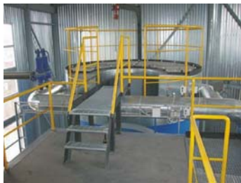
8-MW Danstokeri vertikaalse veekatla ja 10-MW restkolde pealtvaade
