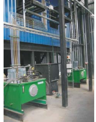
10-MW mehaanilise restkolde ja tuhaärastuse hüdraulika agregaadid
