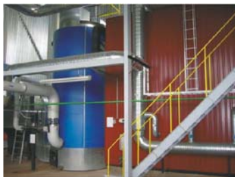
3,5-MW Danstokeri vertikaalne veekatel ja 4,2-MW restkolde
