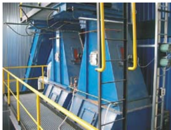
10-MW mehaanilise restkolde kütuse hüdraulilised sissesööttjad
