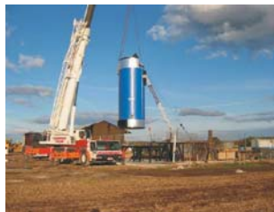
35-tonnise kaaluga katla montaaž
