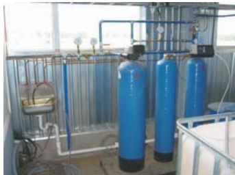
Katlavee automaatne rauaärastuse ja pehmduse süsteemi filtrid
