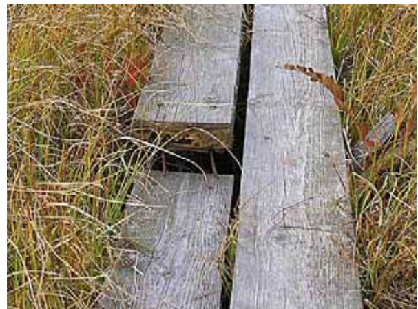
Matkarada rabas. Pehkimise tõttu on rada muutunud ohtlikuks ja vajaks parandamist.
