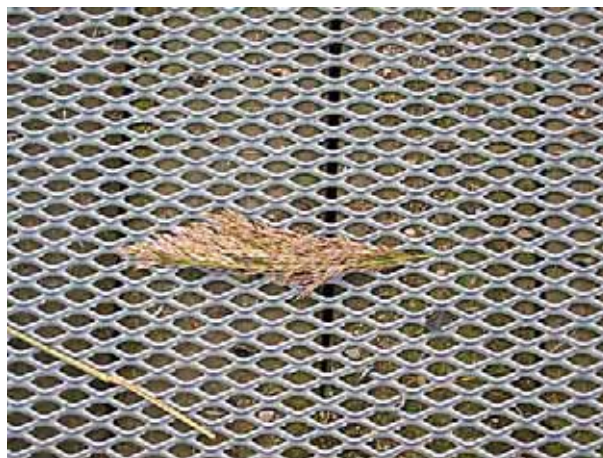
Lähivaade põrandal kasutatud võrematerjalist.
