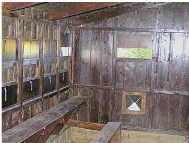
Luukidega vaateavad, mida saab keti abil reguleerida. Avad on kahel erineval kõrgusel, arvestades inimeste erinevat kasvu. Alumistest vaateavade allpool olevale riiulile saab küünarnukke toetada. NB! Hästi madalal olev avaus võimaldab maapinnal olevate lindude pildistamist.
