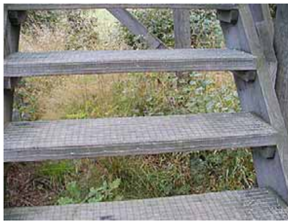
Liiga järskudele trepiastmetele on paigutatud võrk, mis vähendab libedust märja ilma puhul.
