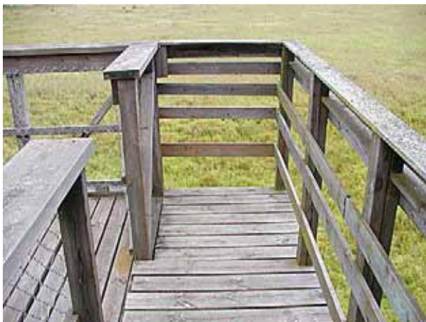
Horisontaalselt asetatud lauad, mis lausa kutsuvad ohtlikult ronima. Suured avaused, kust lapsed võivad läbi mahtuda.
