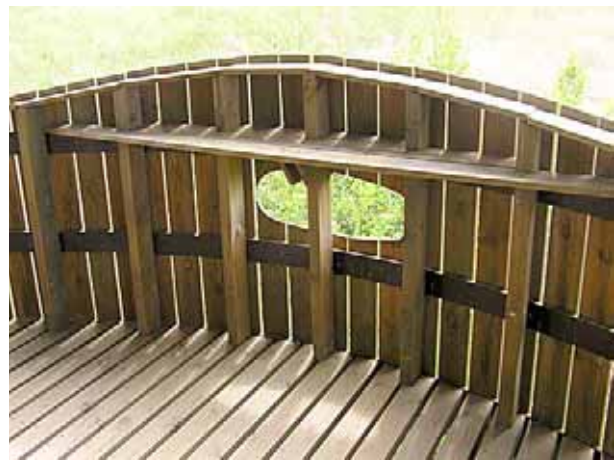
Hea näide väikeste avaustega piiretest, kust lapsed saavad läbi vaadata. Ohutuse aspektist peaks keskel asuv ovaalne avaus olema pisut väiksem.
