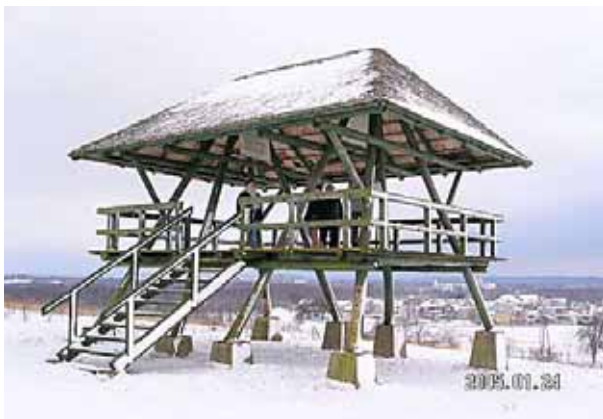
Näide kõrgendiku kasutamisest – maastiku varieeruvuse tõttu ei peagi torn olema väga kõrge hea vaate jaoks.
