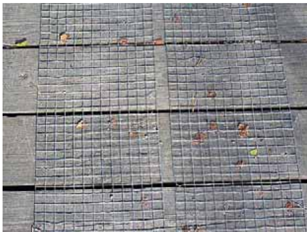
Teerajale paigutatud metallvõrk hoiab ära libedusest põhjustatud õnnetusjuhtumid.
