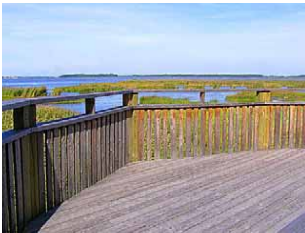
Hea näide piirdest – kõrge, stabiilne, ei võimalda ronimist. Samas on jäetud vaatamisavaused laste ja ratastoolis inimeste jaoks.
