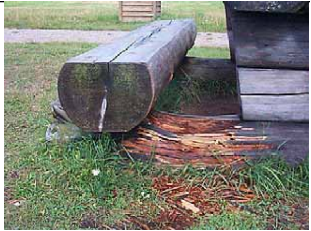
Paigaldatud otse maapinnale. Juba mõne aasta pärast algas pehkimine.
