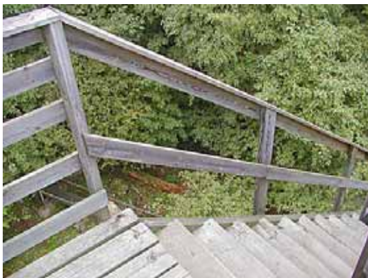
See järsk trepp on kukkumise korral väga ohtlik. Trepi kõrgus ja suurte vahedega piirded suurendavad riski veelgi.
