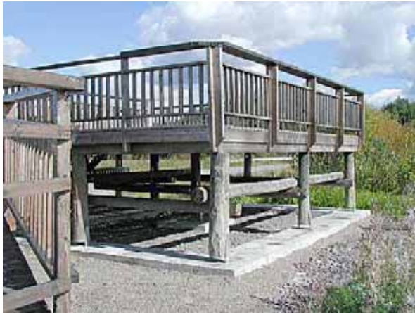
Näide heast vundamendist. Puitraamistiku ja vundamendi eraldatus takistab vee imendumist.
