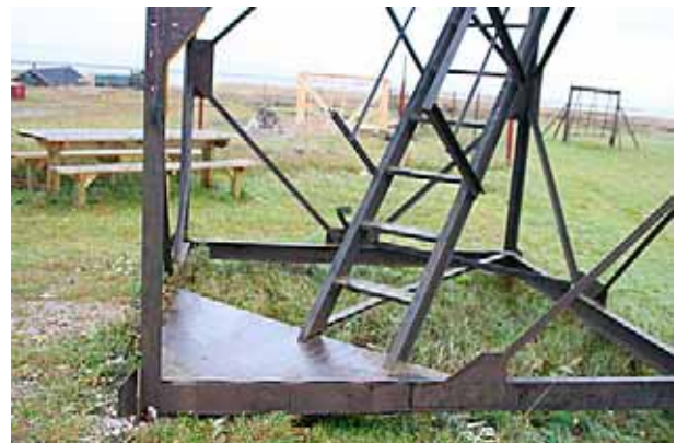
Kõrge ja järsk trepp kitsaste terasastmetega võib põhjustada kukkumist.
