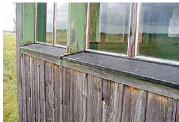
Puidu hingamist takistav värv on põhjustanud akende pehkimise. Värvimata osad on ka 50 aasta järel heas seisundis!
