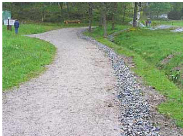
Erineva värvi ja struktuuriga maapind hõlbustab nägemispuudega inimesel raja kasutamist.
