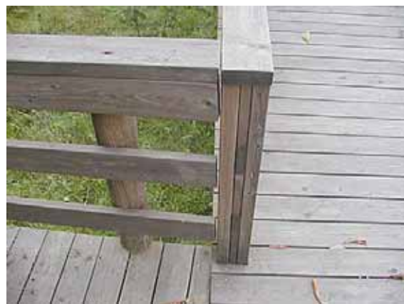
Vibratsiooni vähendamiseks on kaldtee platvormist eraldatud. Siin tuleb vajumisest tekkinud tühimikku pisut kohendada.
