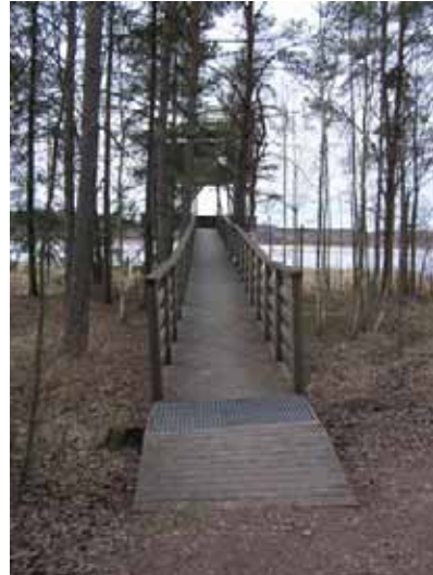
Rest jalgade pühkimiseks kohe kaldtee alguses vähendab torni viidavat liiva.
