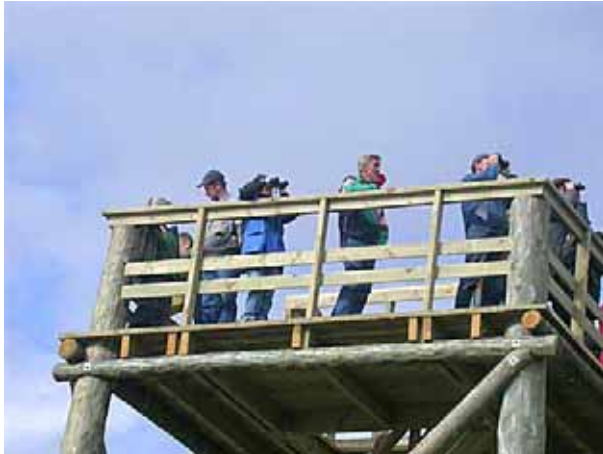
Väga lihtne oleks siin reelingutel ronida. See on suur ohuallikas kõrgetes tornides.
