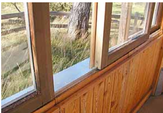
Aknad, mis tuleb avamiseks kõrvale lükata. Vihmavee sissevalgumise takistamiseks ei pruugi ühendused olla piisavalt tihedad.
