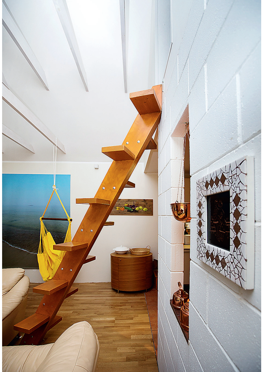
↑ RIIULI moodi trepist pääseb põõningule, paremal on valgeks värvitud plokkidest kergsein, mis kööki ja elutuba ühtaegu eraldab ja ühendab.
