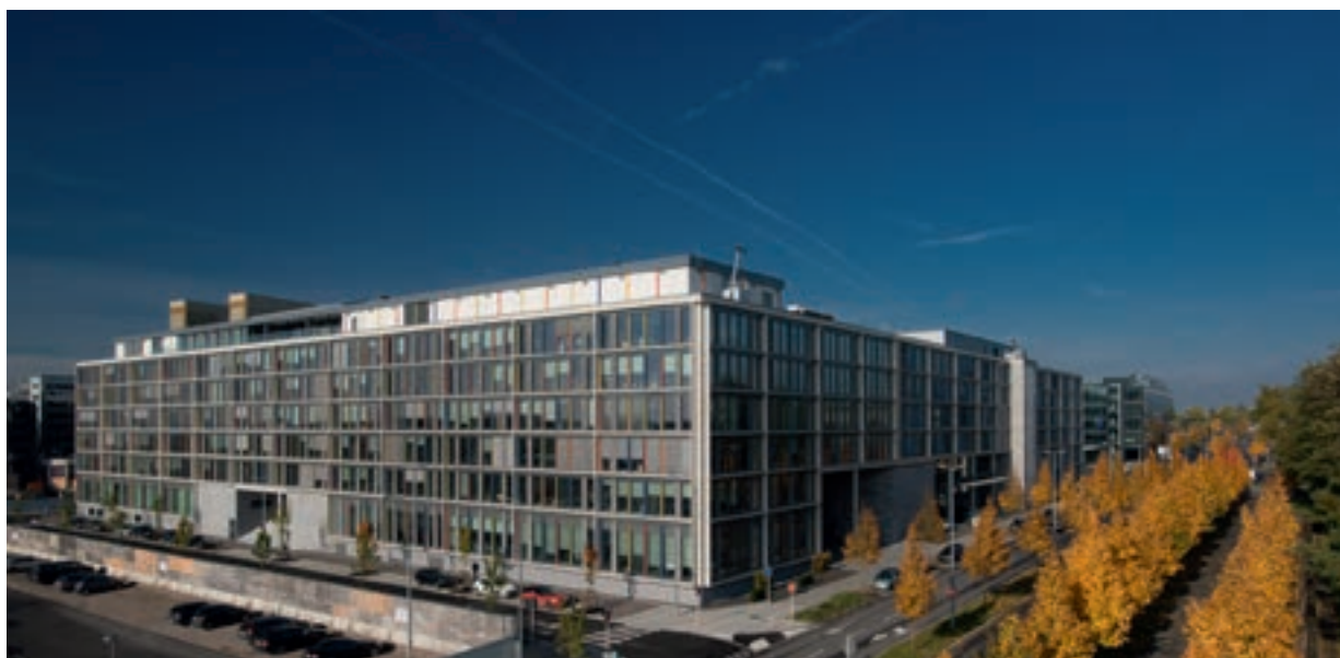
Vaade uuele K3-hoonele, mis on osa kontrollikoja hoonekompleksist Luxembourgis.
