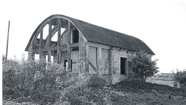
AINULAADNE betoonist talusaun (ehitatud 1930) Seieri talus Tartumaal. FOTO: HEIKI PÄRDI
