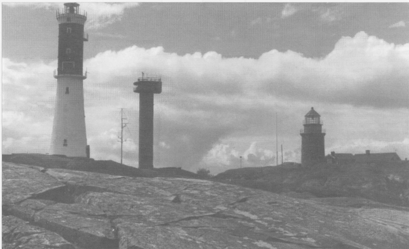
Det finns tre karaktäristiska torn på Understen; Sveriges näst högsta fyr, spaningstornet med sin snurrande radar och den ursprungliga fyren byggd år 1848.
