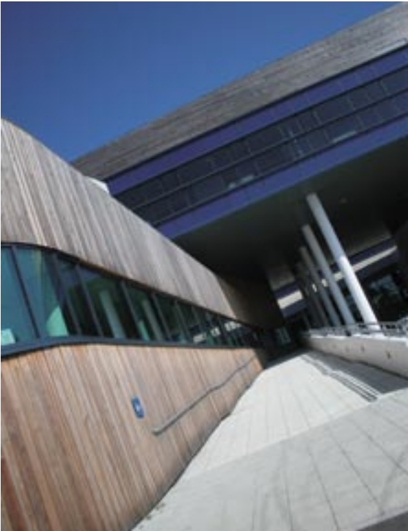
Campus Hub'i arhitektuur Tremough's ühendab kaasaegseid ja traditsioonilisi materjale.
