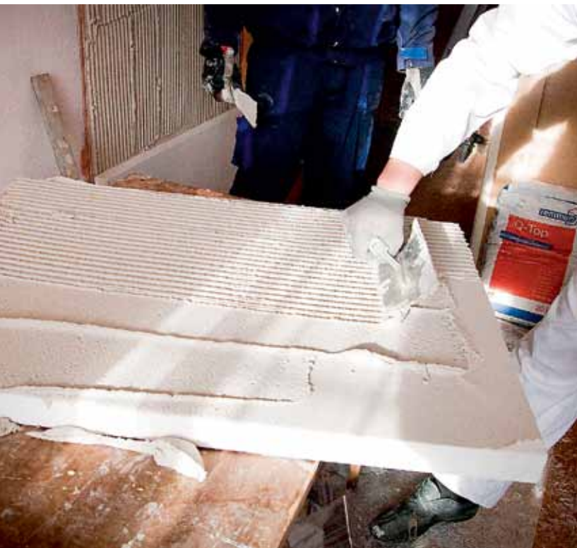
Multipori paigaldamine ja möötmsed.
