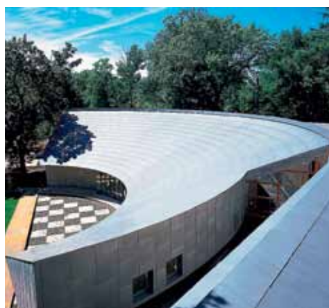
Titaantsinksindlitest katuse- ja fassaadilahendus. Kvaliteetne paigaldus, efektne arhitektuur.
