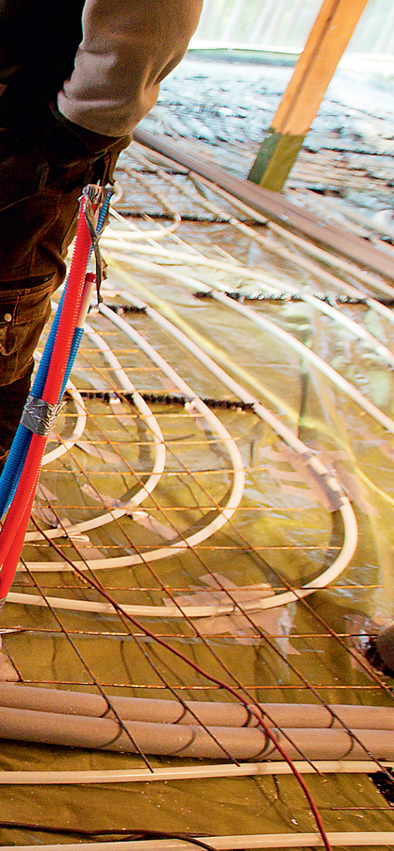
LOHUSALU maja põrandaküttetorustik enne valamistõid. Süsteem on igas toas eraldi paigaldatud ja tulevikus ka eraldi reguleeritav.
