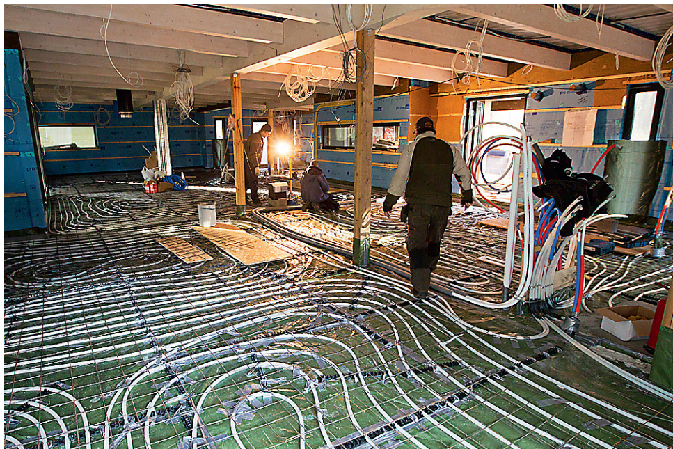
LOHUSALU maja põrandaküttetorustik enne valamistõid. Süsteem on igas toas eraldi paigaldatud ja tulevikus ka eraldi reguleeritav.
