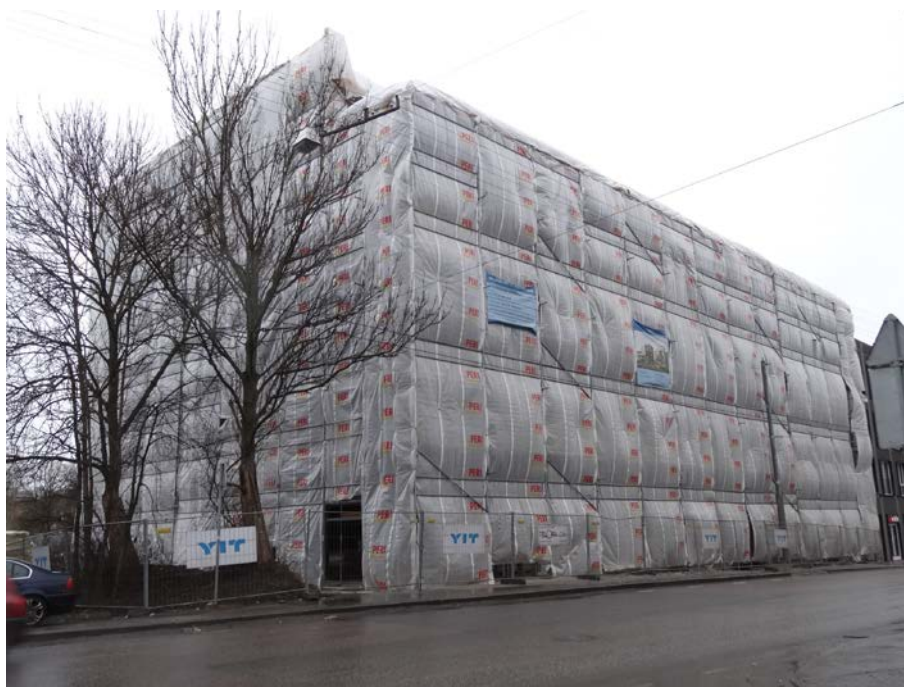
Joonis 2.70 Ehitusaegse märgumise eest on hea kaitsta hoone välisseinad ja katus.
