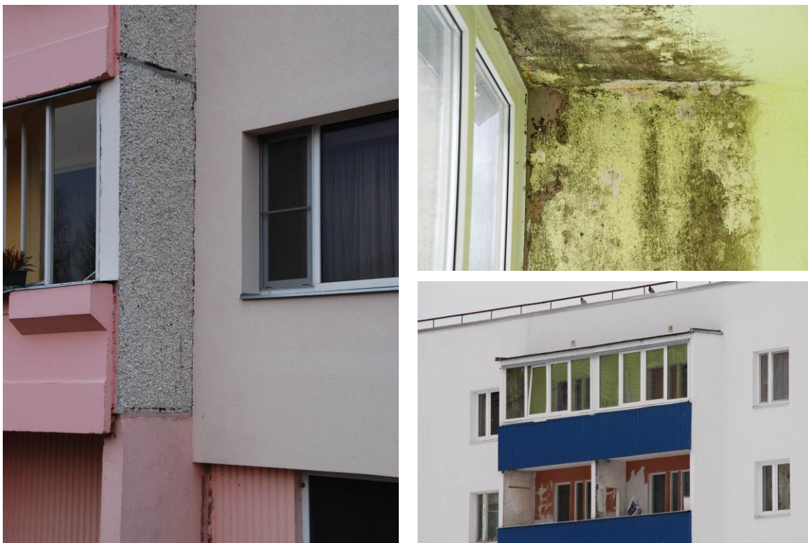
Joonis 2.54 Välisseinte lisasoojustamine peab hõlmama ka lodža seinu (valesti soojustatud vasakpoolsel fotol). Intensiivne hallituse kasv soojustamata seintega lodža sisepindadel (paremal).
