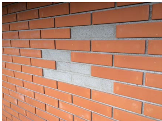
Joonis 2.48 Mahakoornud keraamilise tellise imitatsiooniplaadid krohvitud soojustusel.
