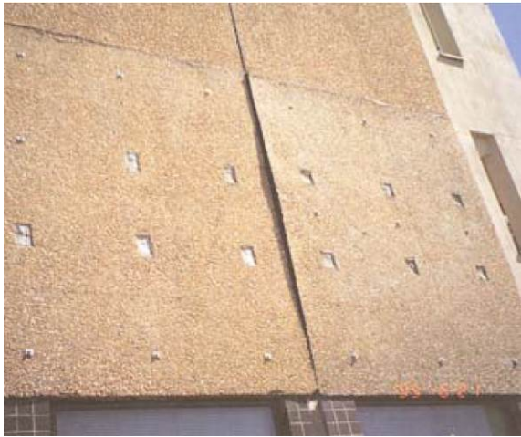
Joonis 2.64 Soomes hoone raudbetoon-suurpaneelist lahti tulnud väliskiht (Julkisivuyhdistys 1997). Sidekivide purunemise tõttu toimunud tellisfassaadi varing Eestis
