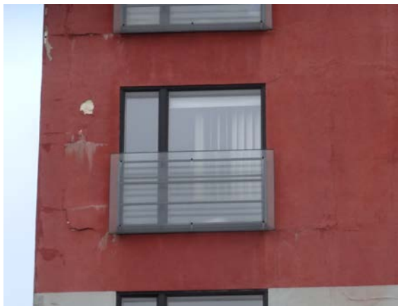
Joonis 2.67 Vee ja selle külmumise koosmõjul on krohv soojustusel hakanud lagunema. Fassaadi katteks tuleb valida selline krohv, mis väldiks vetikate kasvu fassaadil (Joonis 2.68).
