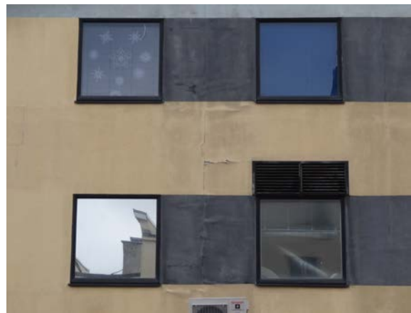
Joonis 2.67 Vee ja selle külmumise koosmõjul on krohv soojustusel hakanud lagunema. Fassaadi katteks tuleb valida selline krohv, mis väldiks vetikate kasvu fassaadil (Joonis 2.68).
