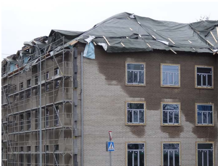
Joonis 2.69 Ebakvaliteetsetest ehitustööde korraldusest märgunud sein enne lisasoojustustööde algust.
