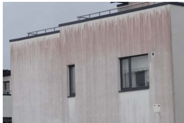
Joonis 2.67 Vee ja selle külmumise koosmõjul on krohv soojustusel hakanud lagunema. Fassaadi katteks tuleb valida selline krohv, mis väldiks vetikate kasvu fassaadil (Joonis 2.68).
