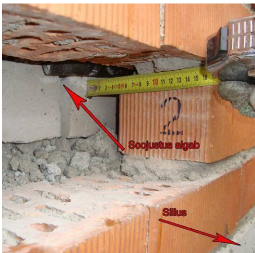
Joonis 2.29 Telliselamu välisseina puudulik soojustus.
