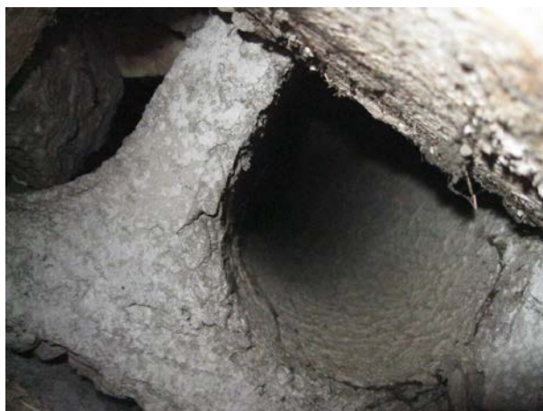
Joonis 3.20 Ehituslik ventilatsioonishaht, kus šahtielemendid ei ole kohakuti ja sukaga saaks seda tihendada.
