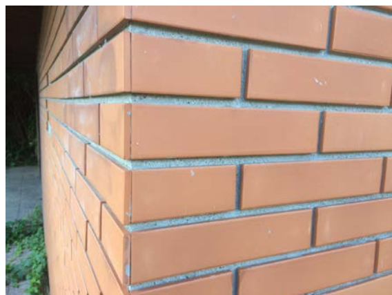
Joonis 2.48 Mahakoornud keraamilise tellise imitatsiooniplaadid krohvitud soojustusel.
