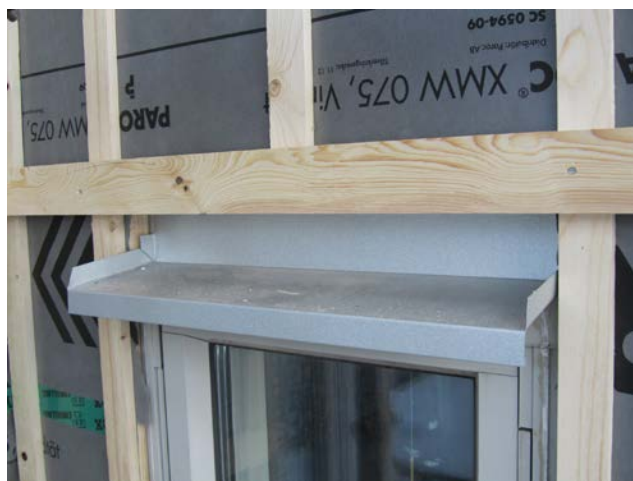
Joonis 2.46 Horisontaalroovide kasutamise peavad need olema perforeeritud (vasakul) või tuleb kasutada topeltroovitus (paremal) et tagada vajalik õhkvahe fassaadi taga.
