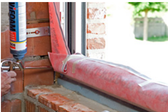
Joonis 2.38 Akna tihendamine tihendustepipdega.
