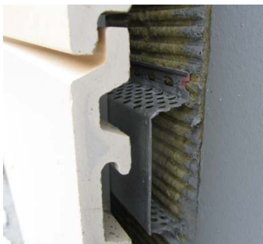
Joonis 2.46 Horisontaalroovide kasutamise peavad need olema perforeeritud (vasakul) või tuleb kasutada topeltroovitus (paremal) et tagada vajalik õhkvahe fassaadi taga.
