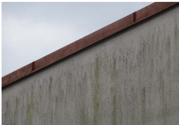
Joonis 2.68 Vetikate kasv krohvitud fassaadil.
