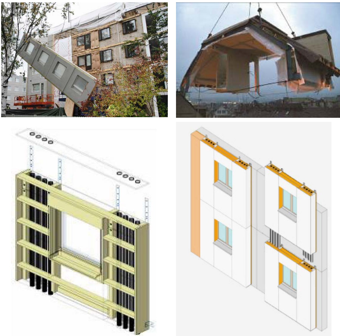
Joonis 2.66 Eelvalmistatud moodulpaneelide kaudu hoonete lisasoojustamine ja renoveerimine ( http://www.empa-ren.ch/A50.htm , http://www.tesenergyfacade.com , http://www.paroc.fi/kampanjat/Innova-projekti ).
