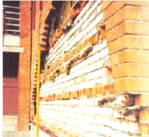
Joonis 2.64 Soomes hoone raudbetoon-suurpaneelist lahti tulnud väliskiht (Julkisivuyhdistys 1997). Sidekivide purunemise tõttu toimunud tellisfassaadi varing Eestis
