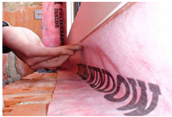
Joonis 2.37 Akna paigaldus soojustuse tasapinda kinnituskronsteinidega.
