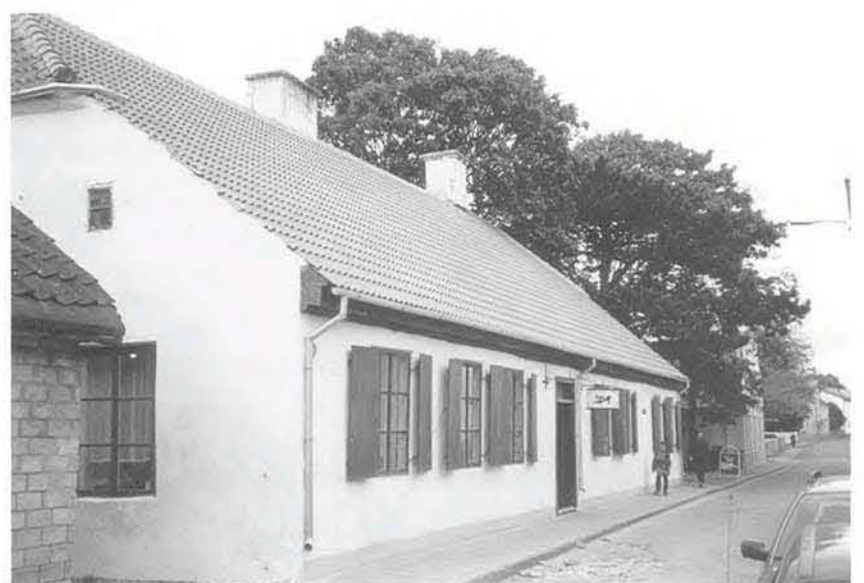
Kauba 11 Kõrgete viilkatustega vanemad hooned mõjuvad massiivselt. Neile hoonetele on tüüpiline, et katused ei ulatu üle otsaviilu. Maja on läbi aegade kasutanud kaupmehed, klassespad, kingsepad, kullassepad, plekksepad, rätsepad ja sadulsepad.
