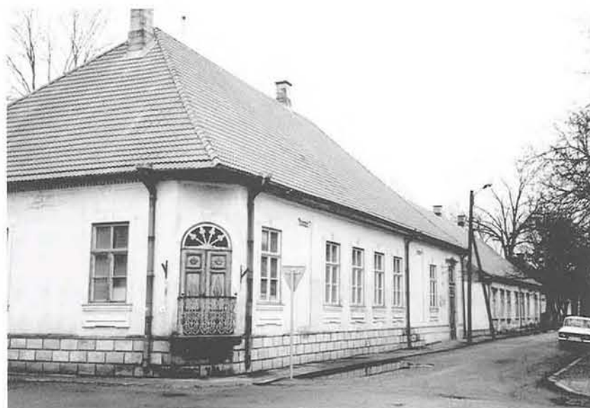
Komandandi 9 18. saj. lõpul rajatud klassitsistlik hoone on ehitatud tahutud dolomiitplokkidest soklile. Maja on traditsioone loov ehitis linnas – iseloomulikud kõrge punane kivikatus, dolomiidist uste ja akende raidraamistused, stiilne tahveluks ja omapärane nurgarõdu teevad majast ühe Kuressaare silmapaistvama hoone. Hoone rekonstrueeriti 1979. a. Arhitektid A. Kukkur ja R. Raie.
