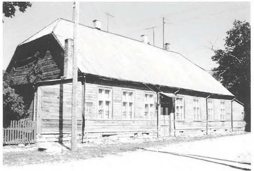
Väike-Sadama 10 Kõrge poolkelpkatusega puitelamu, mille maht on tavalisest suurem meenutades massiivseid vanalinna kivimaju.
