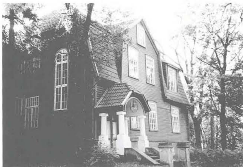
Lossi 27 Romantilises miljöös asuv, O. von Ekesparrele rajatud elamu pärineb 1909. a. Hoonel näeme Kuressaares ainulaadsena saksa heimatstiili elemente: asümmeetriline plaanilahendus, peasissekäigul neljale massiivsele dolomiitsambale toetuv varikatus, kõrge sokkel, eri suuruses väikeseruudulised aknad. Ehitise tagafassaadil taastati 1980. a-tel puitrõdu.
