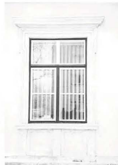
Tallinna 15 Dolomiitraamistuses aken.
