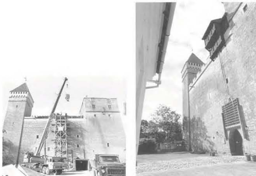
1980. a-tel toimunud restaureerimistöde käigus taastati arhitekt K. Aluve jooniste järgi konventihoone fassaadil värvat kaitsev langevõre ja noolekoda. Fotod 1980. a-test ja 1998. a.
