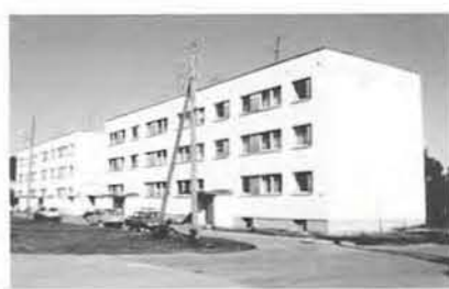
Tüüpelamud Tallinna tänaval. Foto 1980. a-test.
