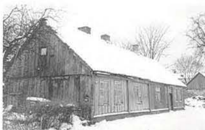
Kohtu 15 Hoonel on säilinud osa algsest vertikaallaudisest ja originaalne profileeritud uksepiire. Siin elas postmeister N. W. von Engel, kelle majas asus 1865.-89. a. postkontor. Puithoonete seinakonstruktsioonist on näha, et algselt olid need tavalised ristpalkseinad, mis hiljem vooderdati väljast laia püstise voodrilauaga.
