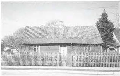
Suur-Sadama 39 Vanas elumajas on säilinud hoone keskel asuv mantelkorstnaga köök, mille ümber paiknevad eluruumid. Hoone välisvooderdus ei ole algsena säilinud.
