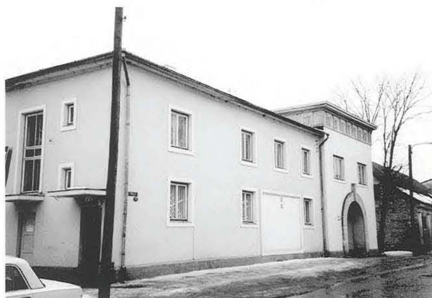
Tolli 1 Saaremaa Keskraamatukogu kahekordset lihtsat hoonemahtu ilmestab peasissepääsu ümberkaar koos lukukiviga. Dekoratiivne katusealune karniis on heaks näiteks dolomiidi kasutusvõimalustest kaasaegse arhitektuuri kujundamisel.
