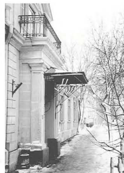
Tallinna 15 Peasissepääs varikatuse ja fassaadirõduga.
