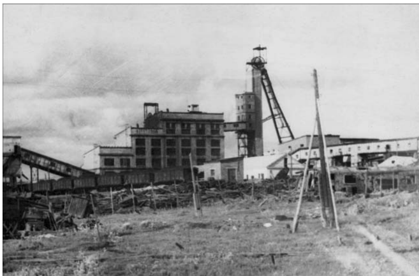
Kaugel põhjas asuva Vorkuta kiviõekaevanduse nr 29 maapealse osa üldvaade, 1955. Kõrge hoone on sorteerimisvabrik, vasakule poole mööda kaldtransportööri, läbi punkrite vagunitesse läheb toodang. Paremale poole suunatakse galeriides asuvate lintransportööridega aheraine (tühimaak). A general view of the ground-level part of coal mine No. 29 in Vorkuta in the Far North, 1955. The tall building is the sorting factory, with the output going to the left, along the slanted transporter, via the bunkers and into the railway cars. To the right is sent gangue (empty ore) on the conveyor belts in the galleries.
