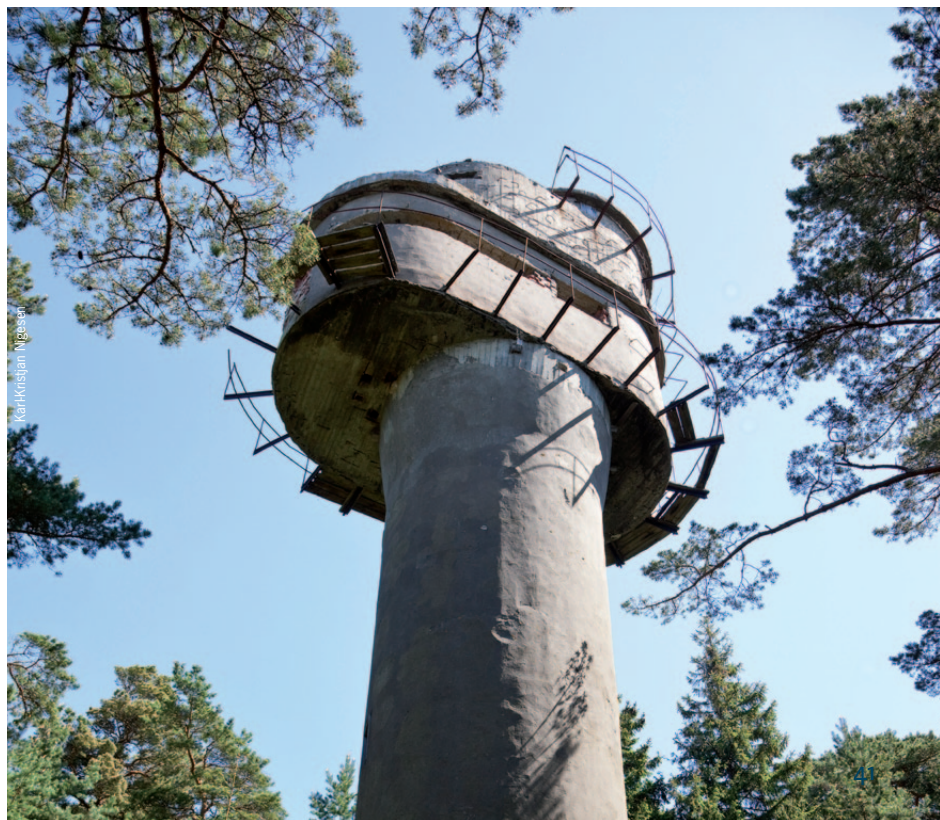
Ristna tuletorni konstruktsioon telliti 1873. aastal Prantsusmaalt Eiffeli tehastest. Ka loo avafotol oleva Tahkuna tuletorni metallkarkass on Eiffeli tehtud, majakas on orestatud suisa Pariisi maailmanäituselt.
