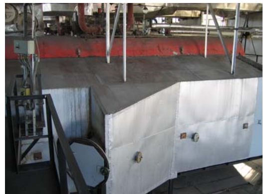
Joonis 8.23. Koht katla küljel vedelkütusepõletit paigaldamiseks, foto Ü.Kask
