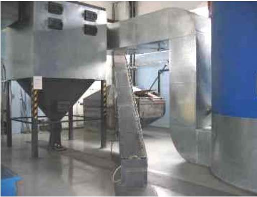
Joonis 8.42. Multitsüklon ja tuha transportöör, foto Ü.Kask
