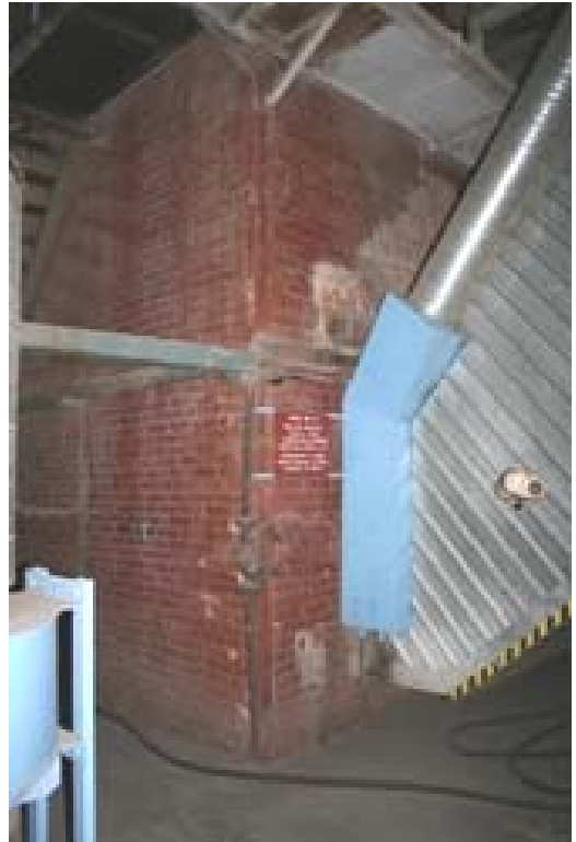
Joonis 8.17. Tertsiaarõhukanali lõpuosa, foto Ü.Kask
