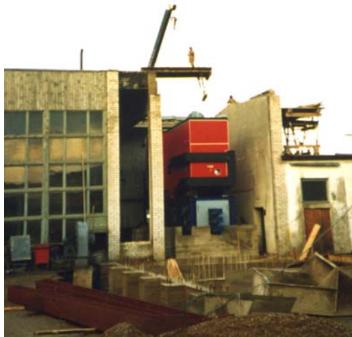
Joonis 8.6. Komplektse biokütusekatla montaaž AS Terme Tehnika katlamajas, foto V.Vares
