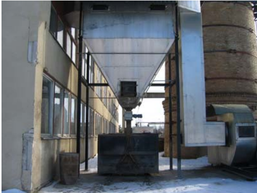
Joonis 8.26. Kivikorsten, suitsuimeja ja tuhakonteiner Võrusoo katlamajas, foto Ü.Kask
