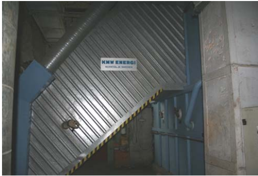
Joonis 8.16. Eelkollet katlaga ühendav käik, foto Ü.Kask
