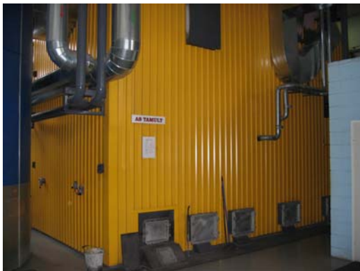
Joonis 8.38. Eelkolle Keila katlamajas, foto Ü.Kask
