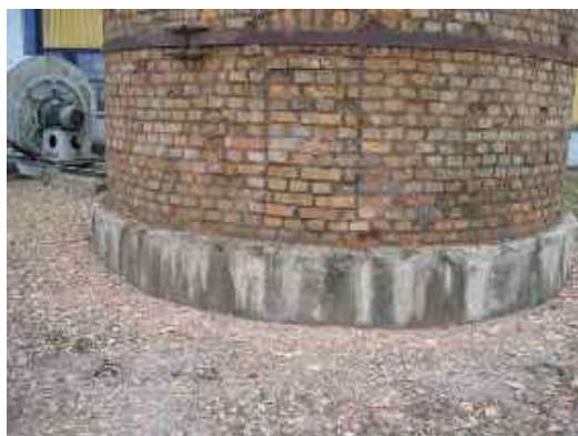
Joonis 8.12. Kivitükikesed laguneva korstna jalamil, foto Ü.Kask
