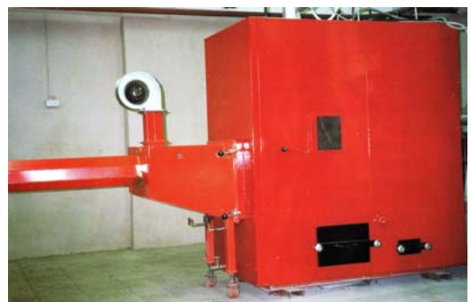
Joonis 4.21. Tallinna Tehnikaülikooli tahkekütuse põleti koos 240 kW universaalkatlagaga
