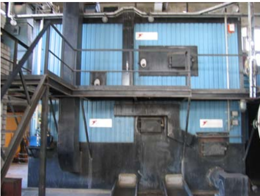
Joonis 8.22. Võrusoo katlamaja paigaldatud eelkolle, foto Ü.Kask
