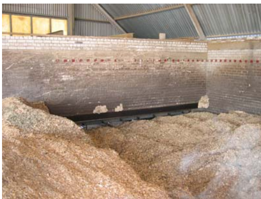
Joonis 8.24. Kütus liikuvate rooplattidega lao osas Võrusoo katlamajas, foto Ü.Kask
