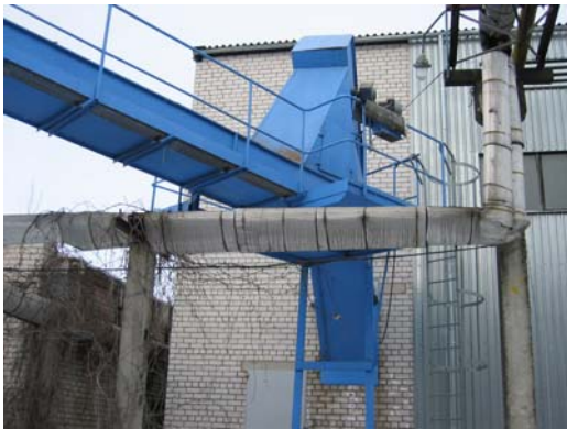
Joonis 8.19. Laost katlamaja suunduvate transportöride ehitamisele jääd ette torustikud, foto Ü.Kask
