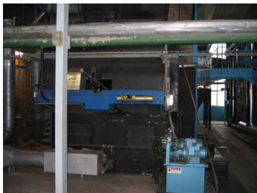
Joonis 8.27. Ümberehitatud DKVR tüüpi katla esiosa, foto Ü.Kask
