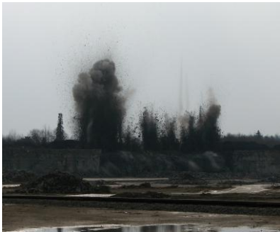
Joonis 52 Puur-lõhketööd( PLT)(foto:A.Õnnis)
