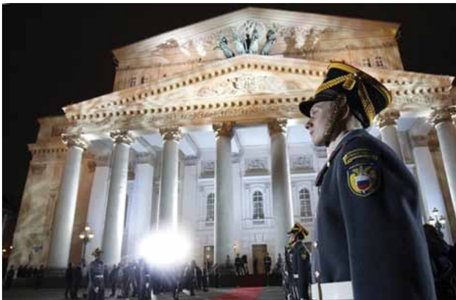
Moskva Suure Teatri fassaad pärast renoveerimist.
