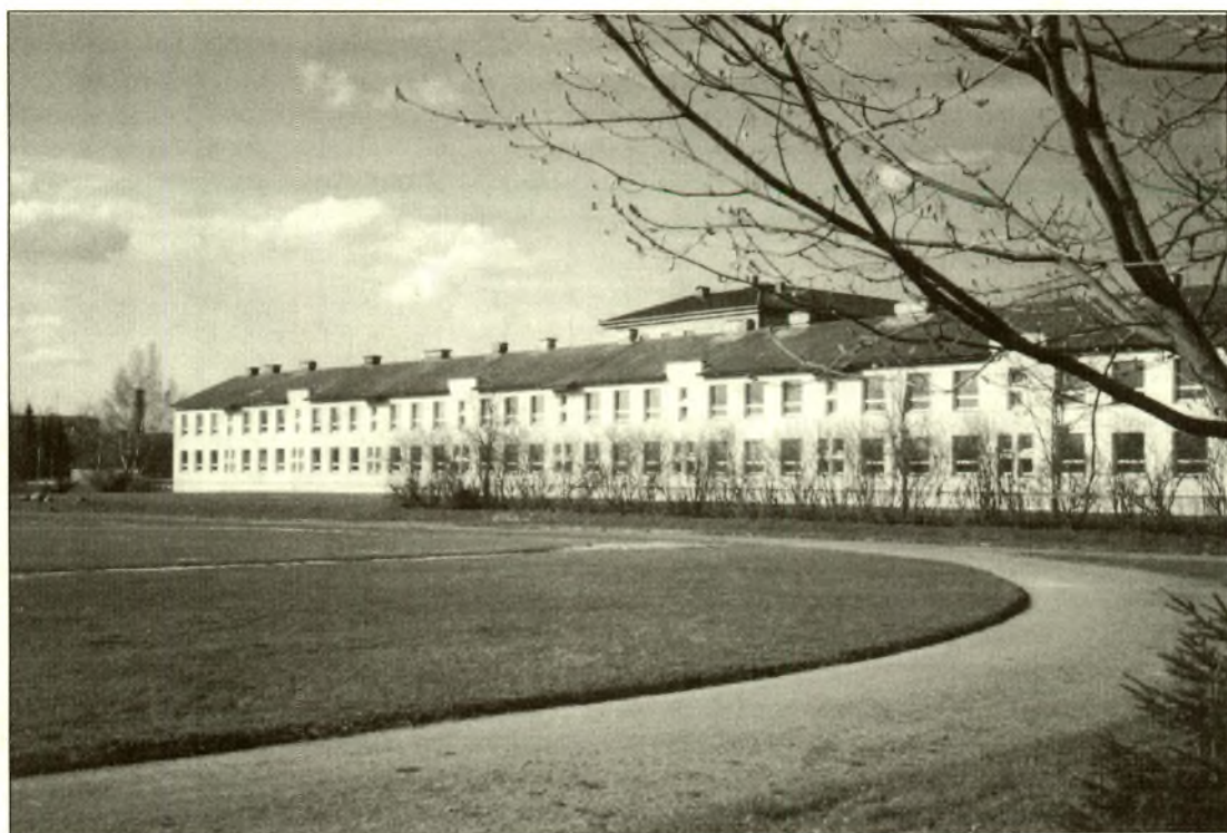
Koolimaja juurdeehitis ja staadion. Näha on taanlaste rahaga vahetatud aknad ja soojustatud välissein.
