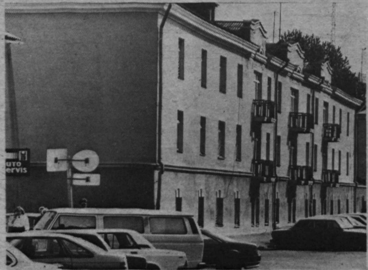
N. Liidu piirivalve staap Eesti Vabariigi esimesel aastal. Nüüd on pikka seina murtud ukseava ja majas käib remont. Kunagi oli see Tollivalvurite maja.
