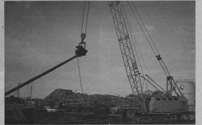
Spoone on rammimiseks pooleldi üles tõstetud.
