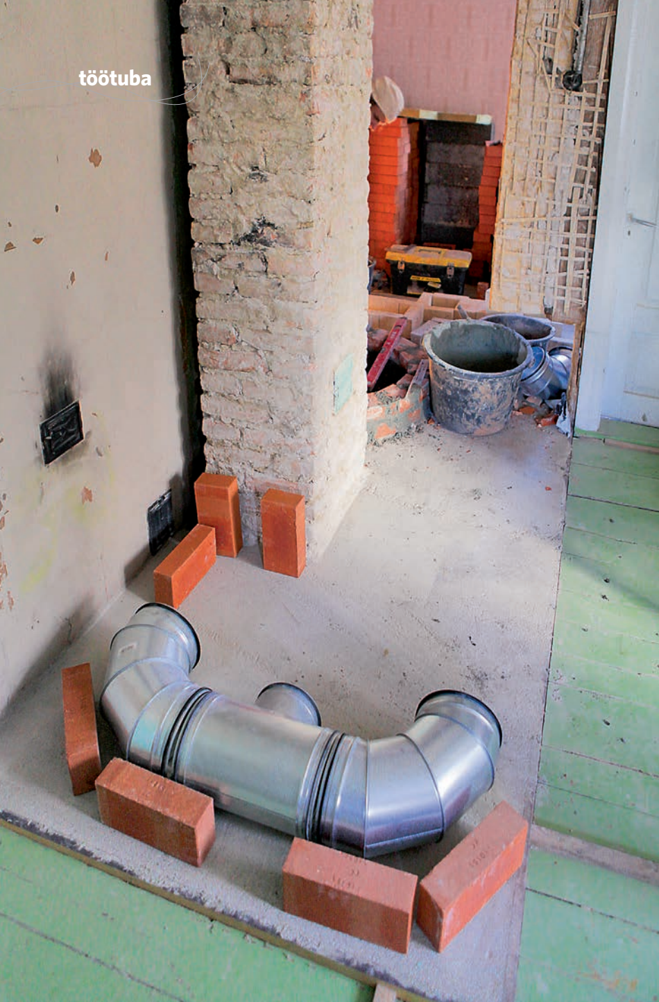
Tulevase leso piirjooned on paigas ja plekktorudki juba hakkamas.
