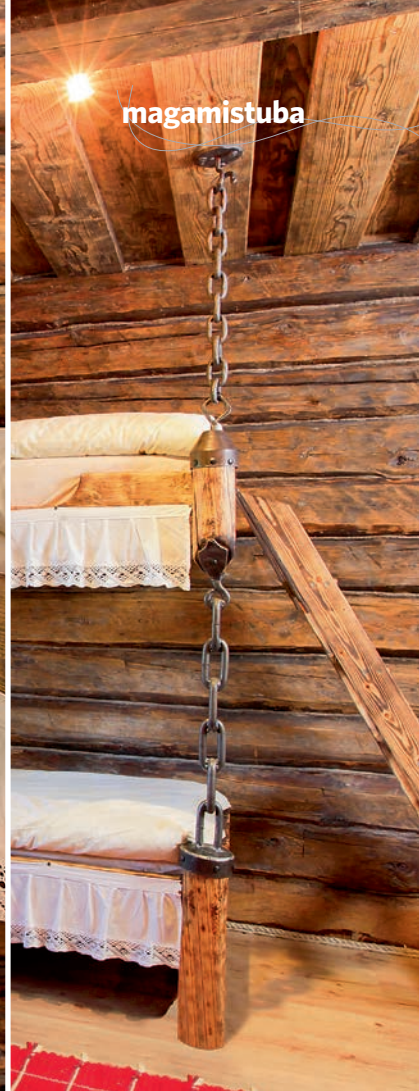
Narivoodit hoiavad ketid, mis on jäigaks keevitatud.
