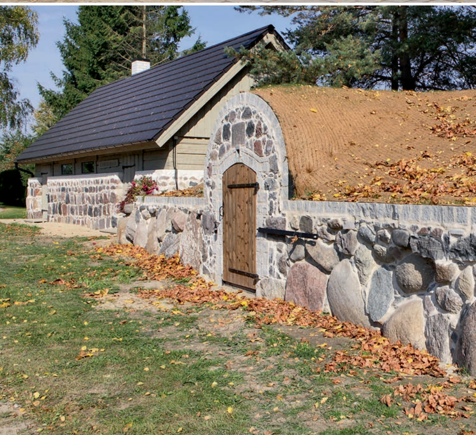
Kaminamaja ja keldri maakivimüüride taastamine oli aeganõudev töö. Tuleval kevadel peaks keldrikatusel tärkama ka muru.
