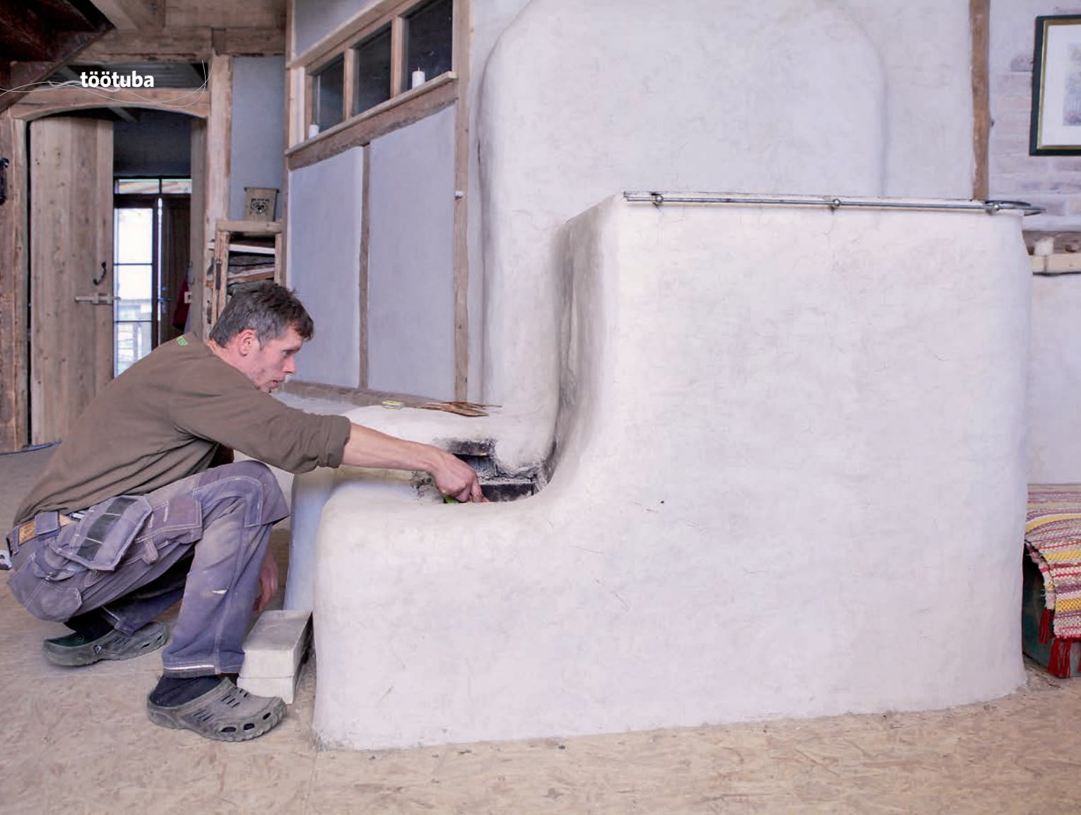
Sven Aluste kodus kütab rakettahi vannitoa seina, lesa ning soojendab tarbevett.
