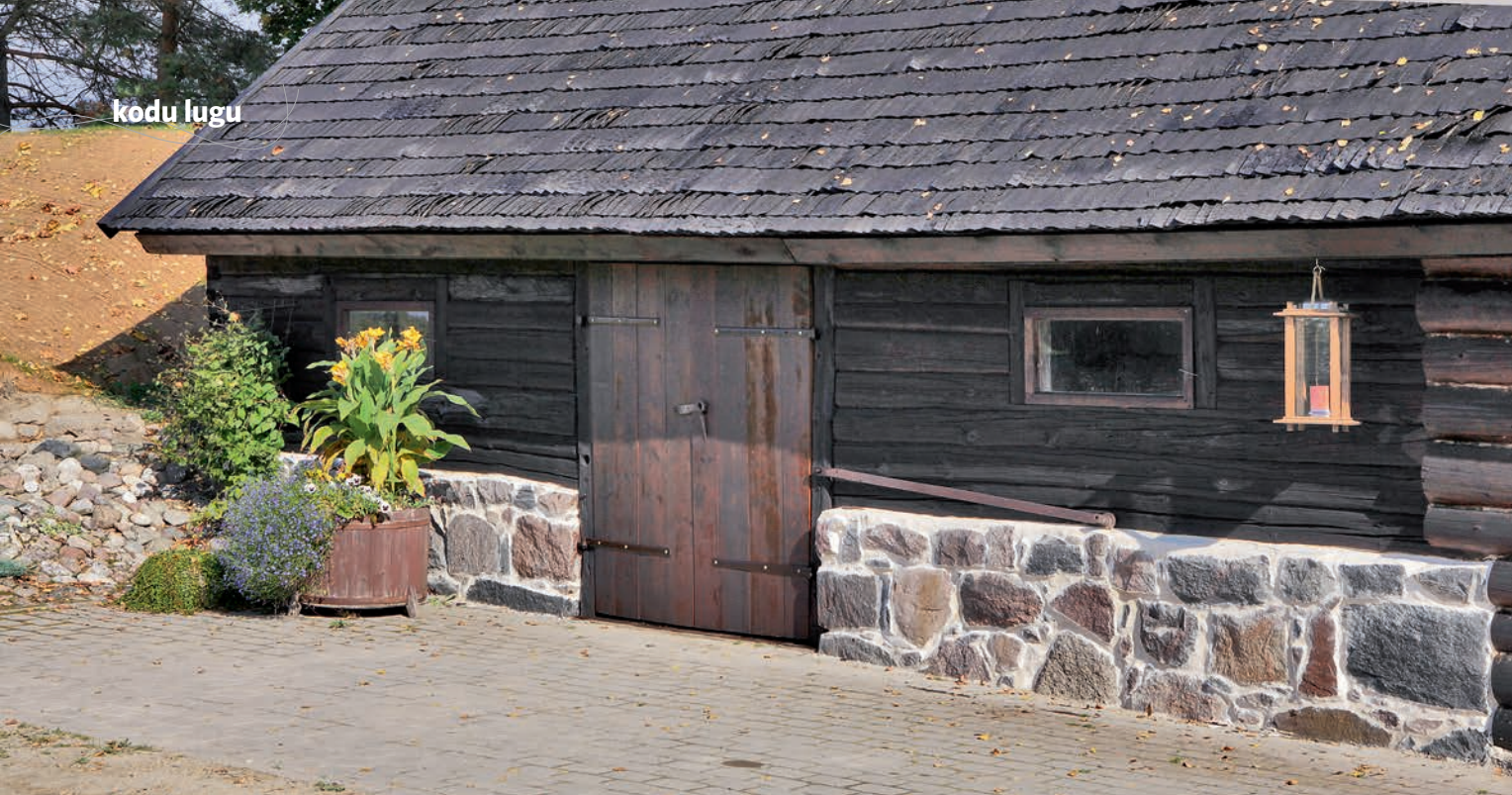
Endine laut ja küün uues kuues: seinad kaeti poolpalgiga, mis võõbati üle Pinotexiga.
