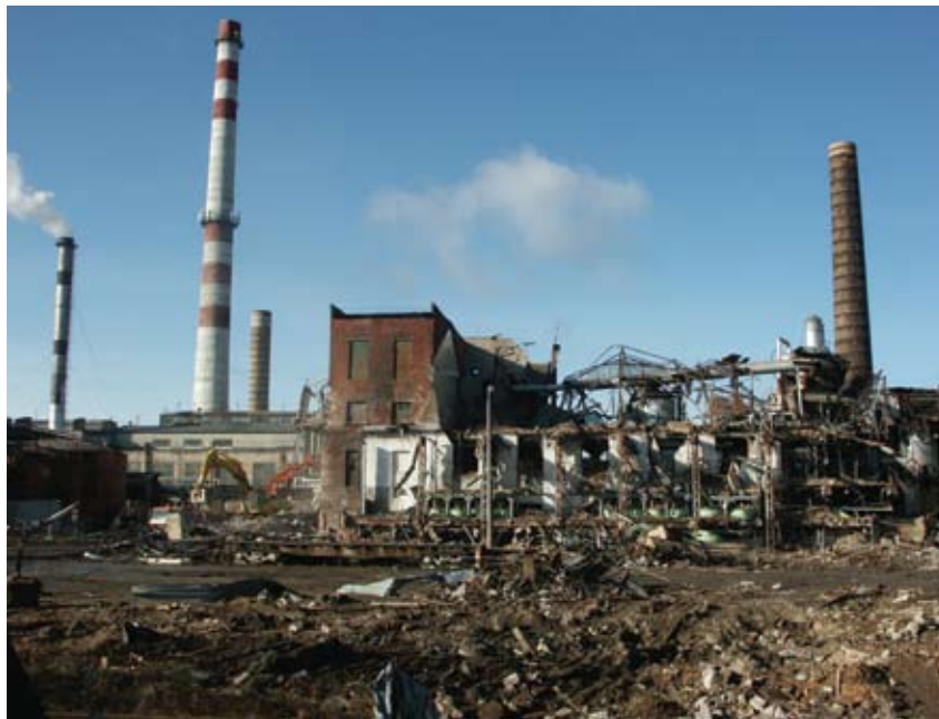
Снос сахарного завода в Елгаве идёт полным ходом.
