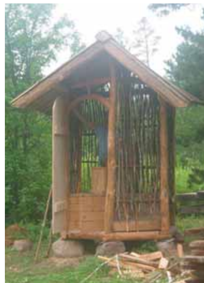
Okstest punatud, veel savikrohvimata seintega kuivkäimla
