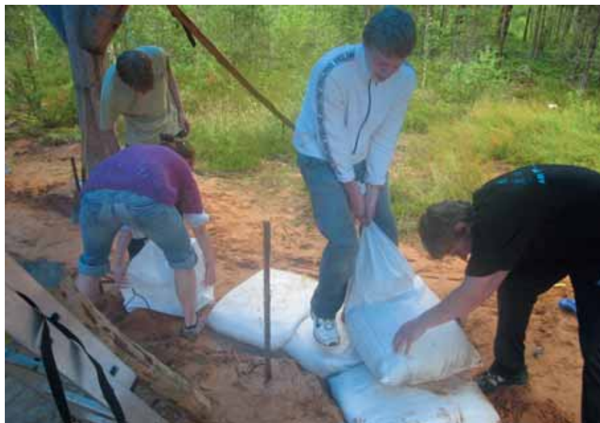
Liivakottidest vundamenti ladumine
