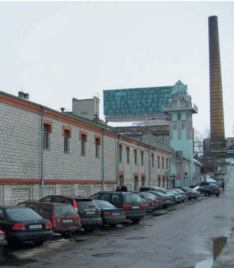
Lastekodu tänav – tsaariaja lõpukümnendite paehoonestuse ühe nädiskvartali lõunakülg, kus kasutati valdavalt Lasnamäe paestu ülaosa Kõrgekalda kihistu alaossa kuuluvaid savika lubjakivi kihte (nr 2–14)
