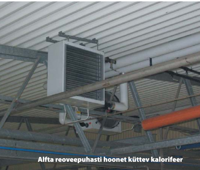
Soojusvahetiga Celpox 1273 Alfa (Rootsi) reoveepuhastis
