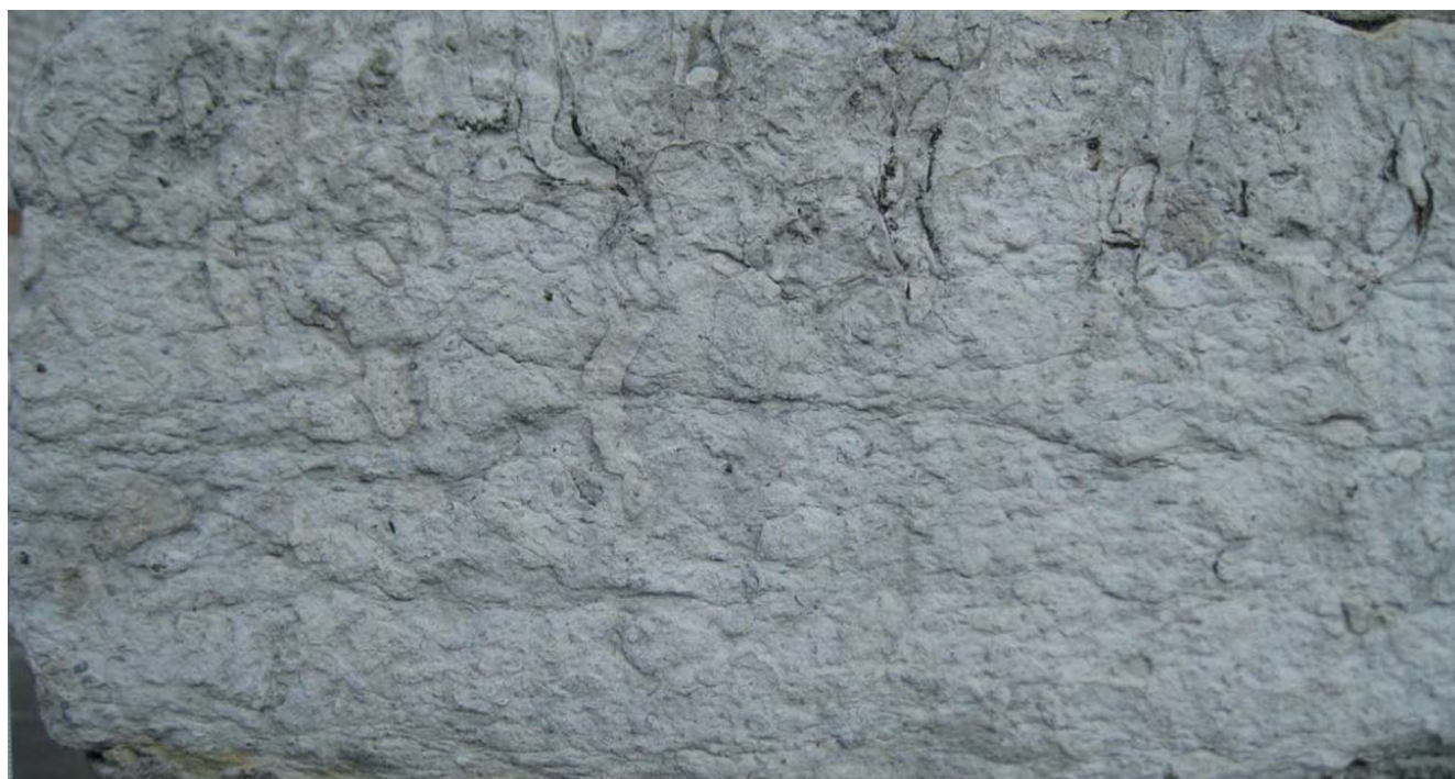
Müürikiviks on /Karvakorra/ (nr 10) lainjate merkivikelmetega nõrgalt savikas lubjakivi, milles on rohkesti ülemiselt katkestuspinnalt algavaid kaevumiskäike. Käigud on pisut looklevad ja ulatuvad kihi keskele, üksikud ka sügavamale
