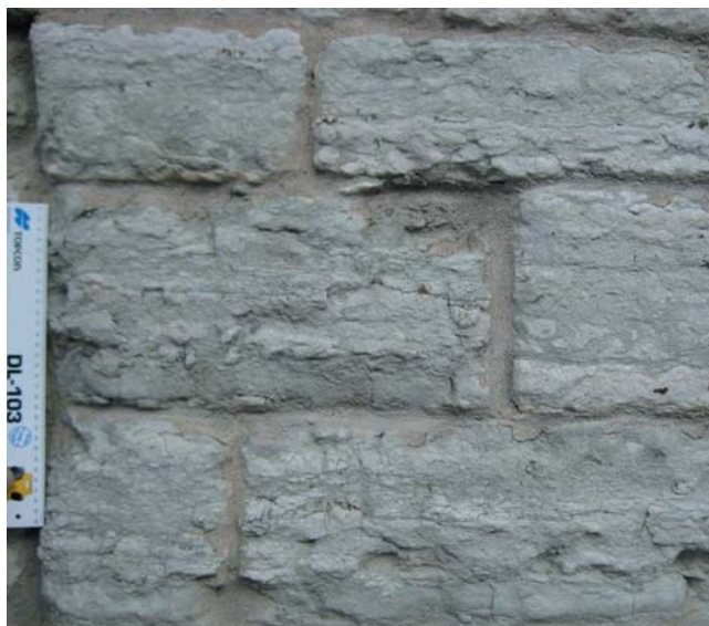
Paemüüri detail Lasnamäe paestu ülaosa tüüpilisest savikast lubimerkivi vahekihtidega paest. Tähele panna püriitseid katkestuspindu lubja- ja merkivikihtide piiril
