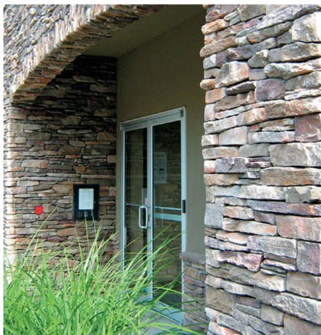
PUR-kõvakattete tehnoloogial viimistletud maja kiviimitatsiooniga kaetud fassaad
