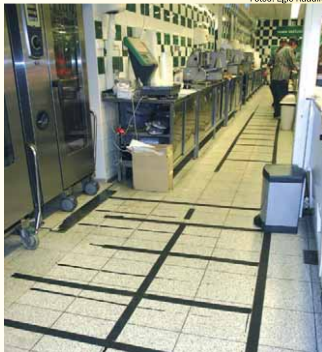
Lihaleti taga kippus põrand alalõpmata libedaks minema. Seetõttu kleebiti maha libisemist takistavad ribad.
