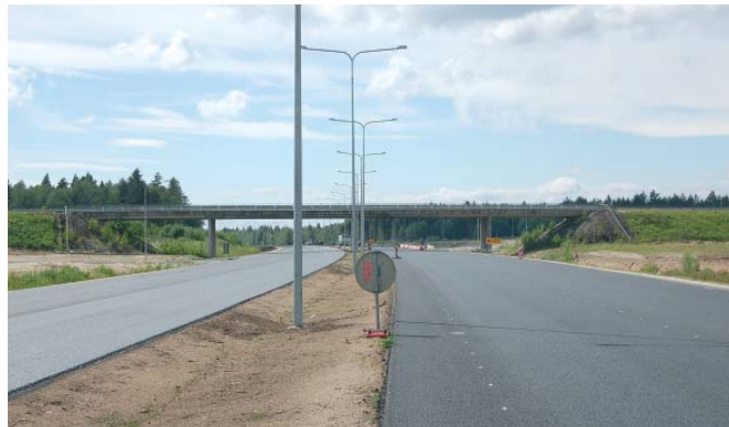
Vaade Viitna viaduktile ja ümbersõidule 9. juunil 2012.
