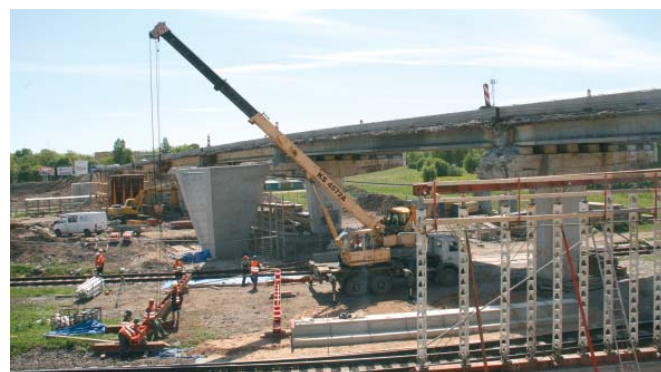
Uue viadukti vahesammaste valmimine osaliselt lammutatud vana viadukti kõrval. Foto: Argo Kotsar 24.05.12.
