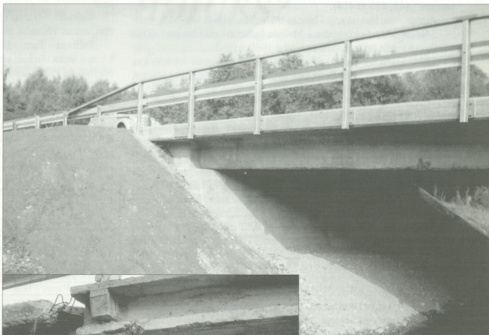
Vardi silla sõidu- ja kõnnitee vaated enne ja pärast renoveerimist (Tallinna - Pärnu mnt. 1997, Raplamaal)
