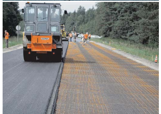
Joonis 3 Pikipragu Laeva–Ilmatsalu lõigul (ülal), 2004. aastal kasutati sellel teelõigul Eestis esmakordselt asfaltkatte pragude sulgemiseks terasvõrku (all) .
