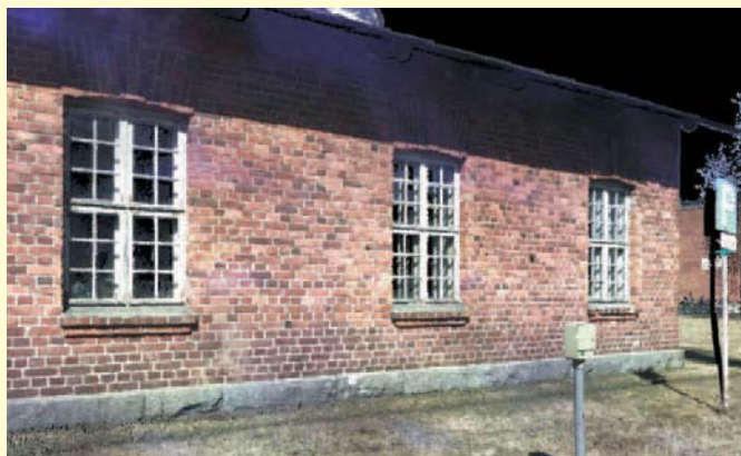
Pilt. Tegemist pole halva kvaliteediga digifotoga, vaid punktipilvega, millele on lisatud naturaalsed värvid, mis on üles võetud laserskanneri oma kaameraga. Igal pikselil sellel pildil on täpsed koordinaadid, mille põhjal saab moodustada ehitise arvuti abil mudeli.
