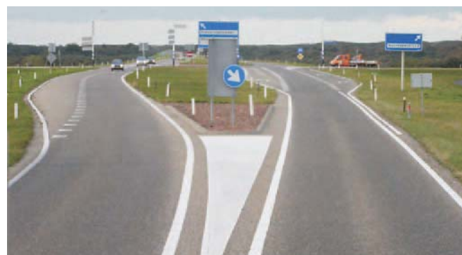
Joonis 6. Konfliktpunktide hajutamine samatasandilisel ristmikul eraldussaarega
