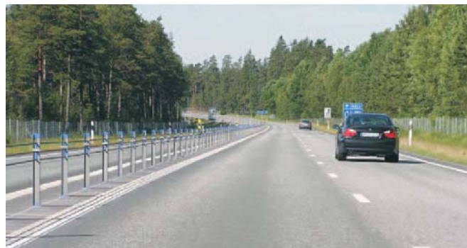
Joonis 5. Eraldatud sõidusuundadega 2 + 1 tee, Jönköping-Göteborg
