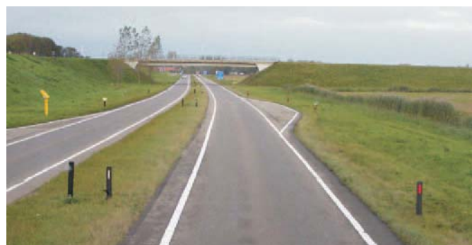
Joonis 4. Eraldusribaga kahe- ja kolme-rajaline tee Hollandis
