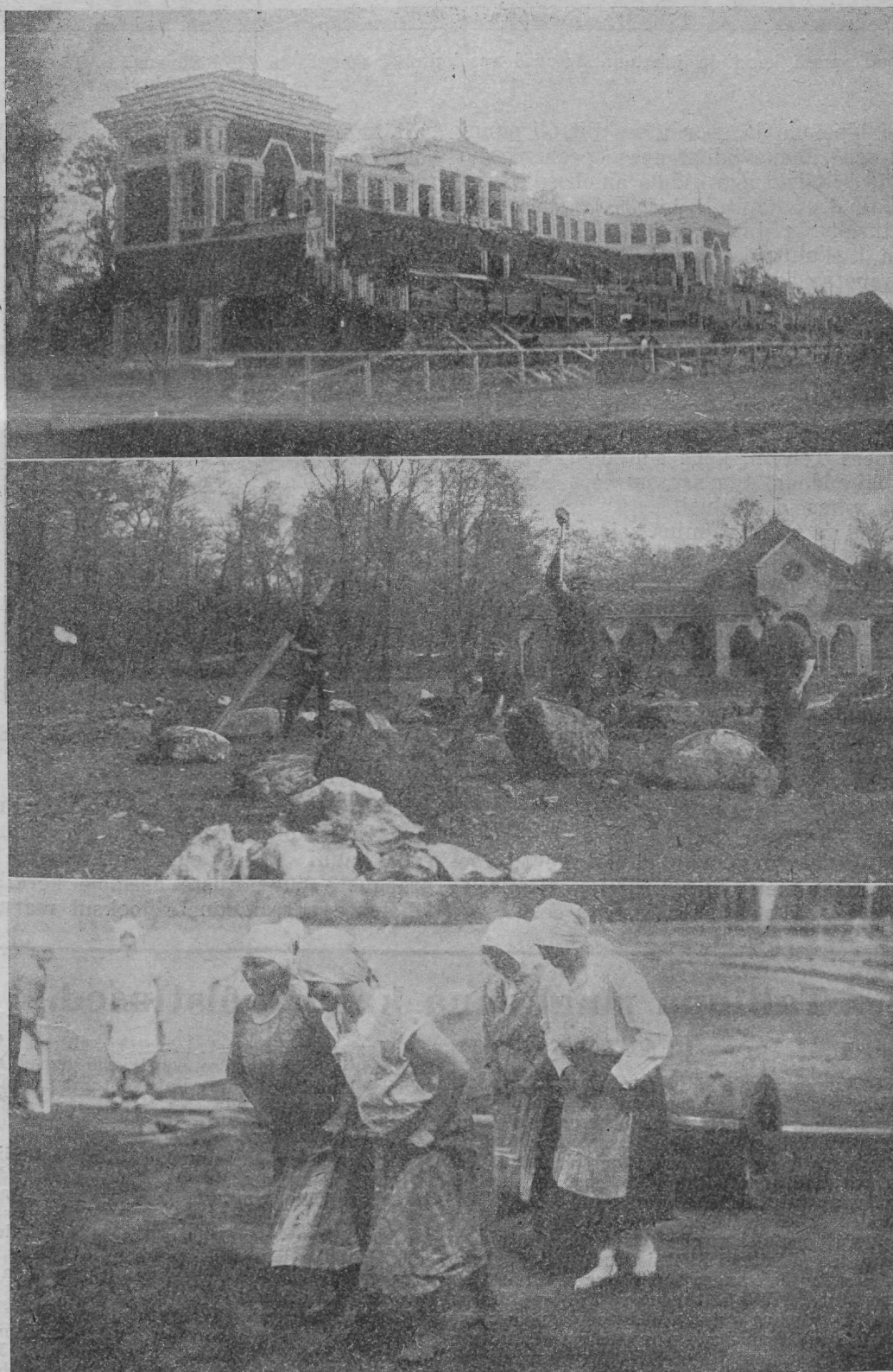
Staadioni saamisloost. Ülemine pilt: Tribüün nädal enne avamist. Keskmine pilt: Kivilõhkumine ja tasandamine staadioni väljal. Alumine pilt: Staadioni jooksutee rullimine.
