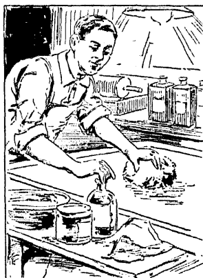
14. Alumiiniumlehe söötmine hapusse vedelikku kastetud käsnaaga.
