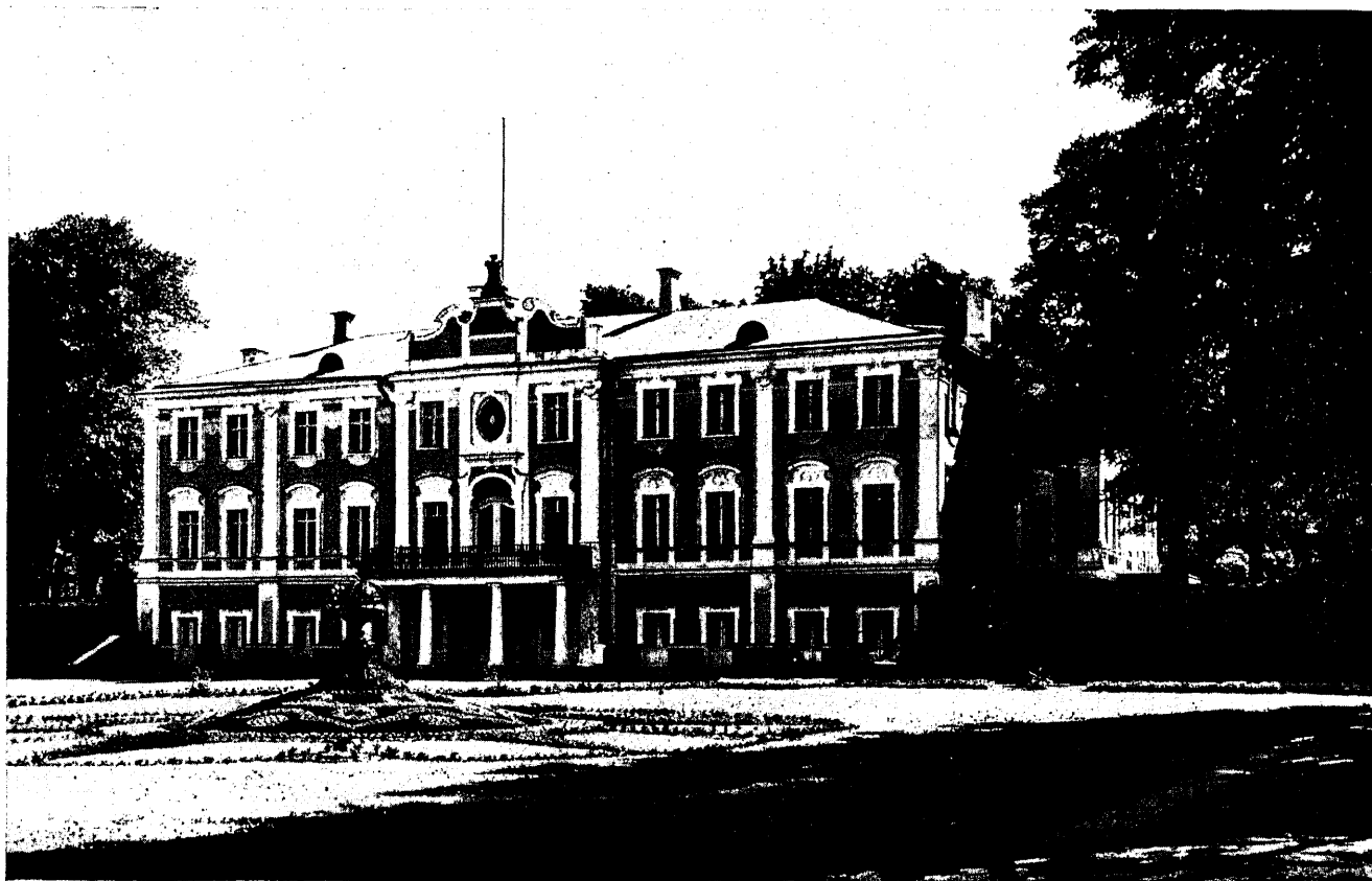
Kadrioru loss. Peafassaad.
