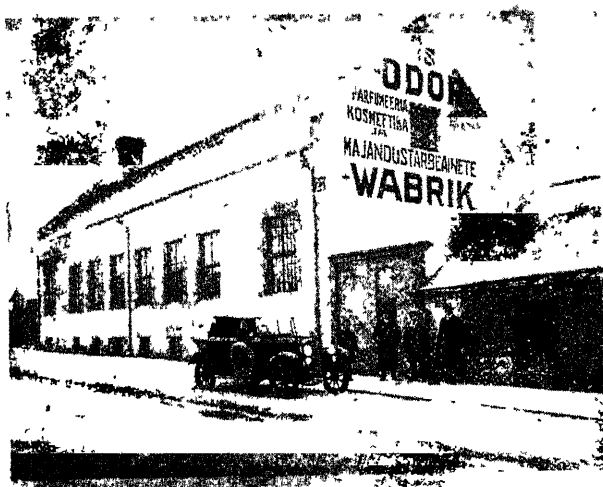
A.-S. „Odori“ vabriku hoone.
