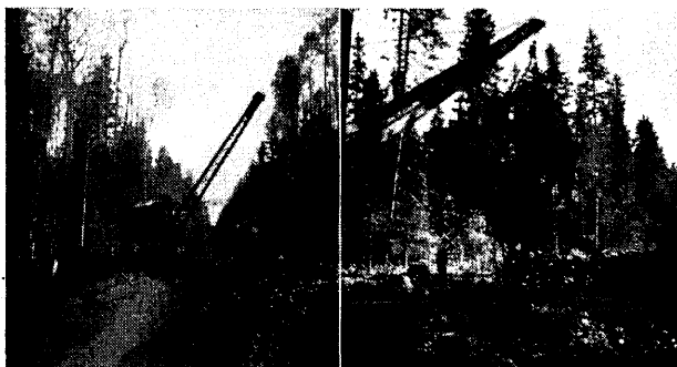
Pilt 3, 6 ja 7. Vasemal: Kitsal metsasihil Kilingi metsk. parvetuskanali kaevamisel 1939. a. Paremal: Lõhkeainega lahtiraputatud kännu tõstab ekskavaator liikumise sihilt kõrvale.
